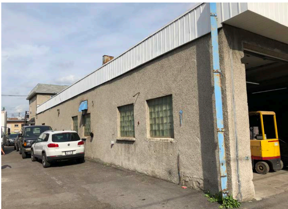
Vue de la façade latérale du bâtiment
