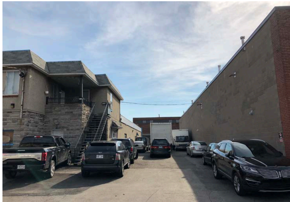
Vue du stationnement adjacent au bâtiment
