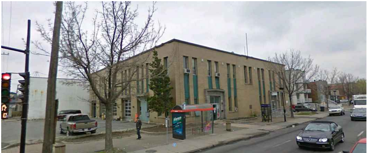
Caserne de pompiers n° 9. Source : Google Earth.
