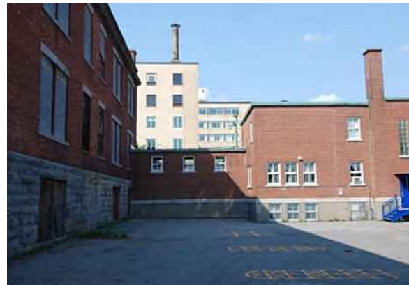
La cour arrière. Source : Mario Brodeur juillet 2012.
