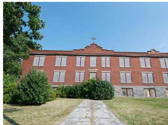
Le parterre dans l'axe monumental. Source : Mario Brodeur, juillet 2012.
