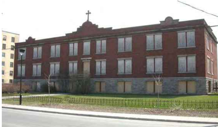
Façade principale – rue Jarry
