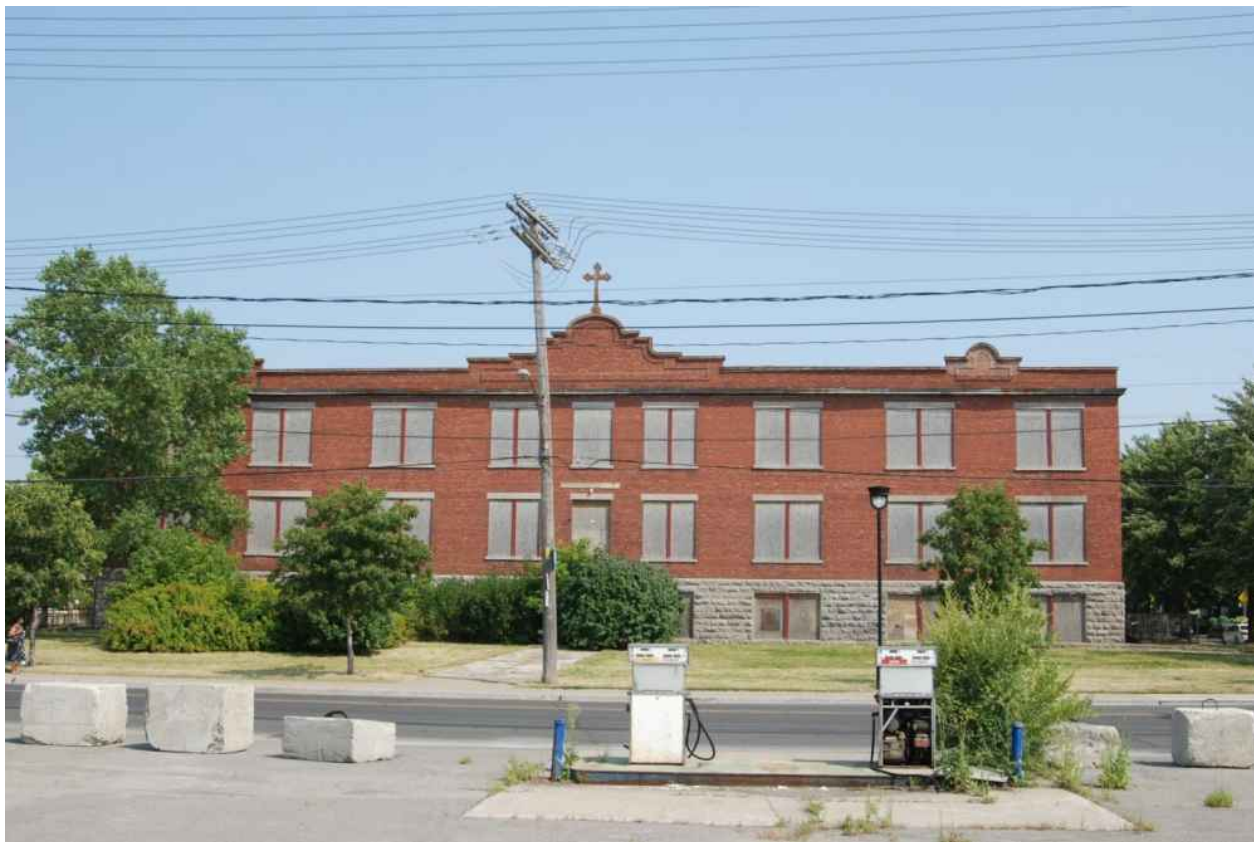
Façade principale (Jarry). Source : Mario Brodeur, juillet 2012.
