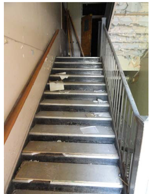
Escalier sud – marches recouvertes de contreplaqué
