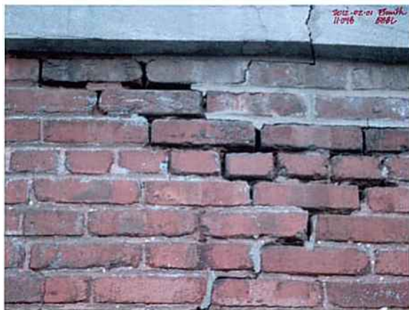
Secteur de joints évidés. Source : BBBL architectes, 2012.
