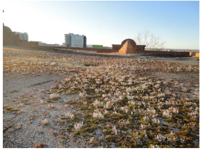
Vue d'ensemble du complexe d'étanchéité – au centre, un drain – à l'arrière plan, un parapet
