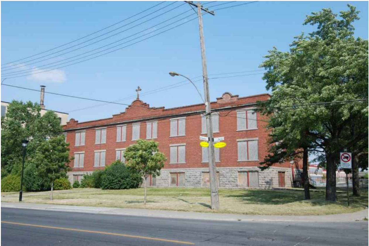
Façades ouest et nord. Source : Mario Brodeur, juillet 2012.
