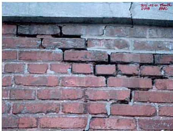
Secteur de joints évidés. Source : BBBL architectes, 2012.
