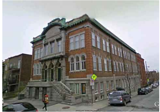
École de l'Enfant-Jésus, 105 boulevard Saint-Joseph Est, construite en 1911-12 (Viau). Source : Google Earth.
