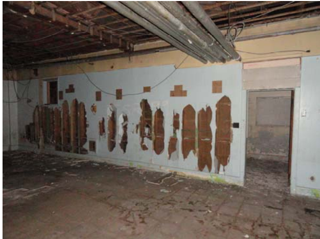
Cloison intérieure vandalisée
