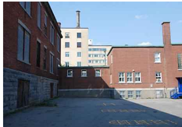
La cour arrière. Source : Mario Brodeur juillet 2012.
