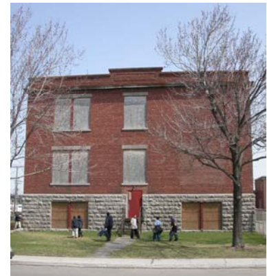
Façade latérale sud – entrée à mi-niveau
