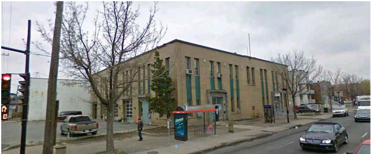
Caserne de pompiers n° 9. Source : Google Earth.
