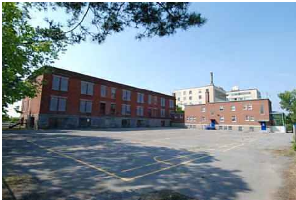
La cour arrière. Source : Mario Brodeur juillet 2012.
