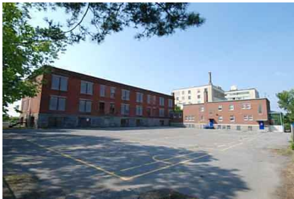
La cour arrière. Source : Mario Brodeur juillet 2012.
