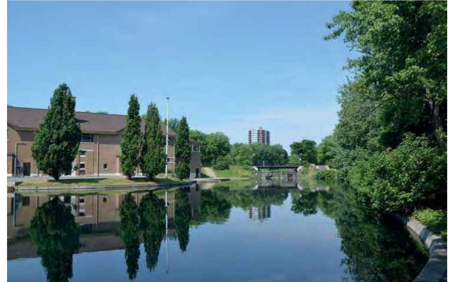
Fig. 3.81 Réflexion des arbres sur le bassin inférieur, 2016.
