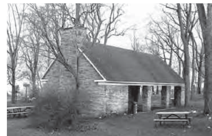
Fig. 3.115 Vespasienne du Petit-Prince, île Sainte-Hélène, construite vers 1965. Fig. 3.116 Abri à pique-nique de la plaine des jeux, construit vers 1955.
