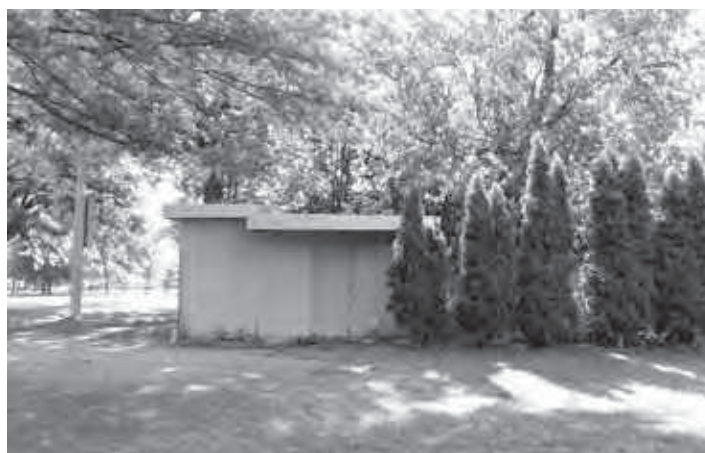
Fig. 3.134 La chambre mécanique de la fontaine lumineuse. Fig. 3.135 Le poste électrique.
