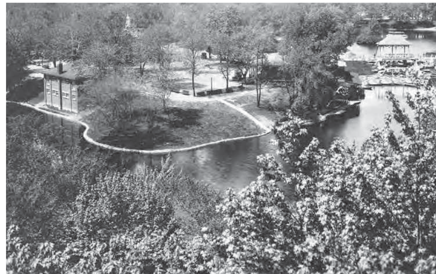
Fig. 3.11 Édifices le long du bassin inférieur, 1935.
