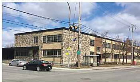
Boul. Châteauneuf / rue des Ormeaux
