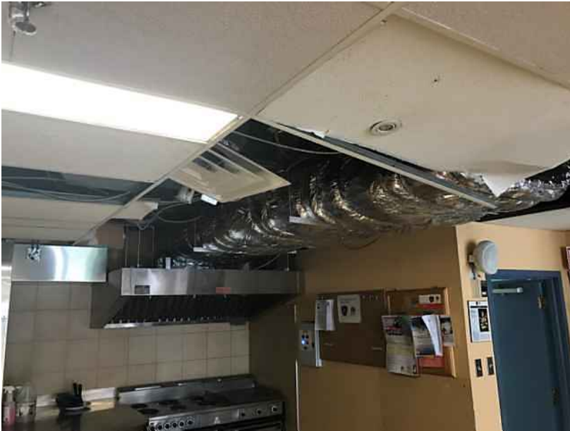
Plafond ouvert dans la cuisine
