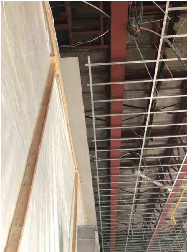
Plafond ouvert dans le garage
