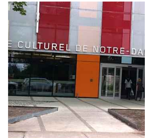
Insertions de trait de scie et jet de sable sur béton coulé
