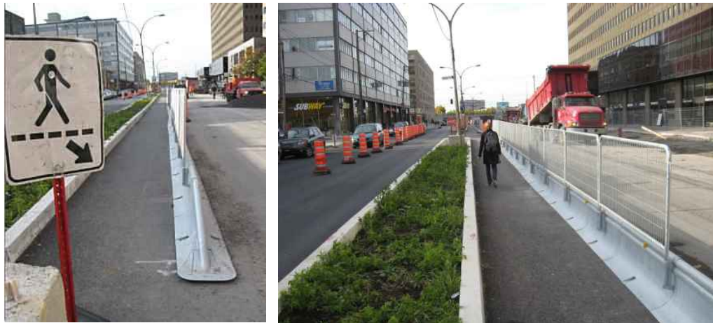
Glissières de sécurité de type MiniGuard
