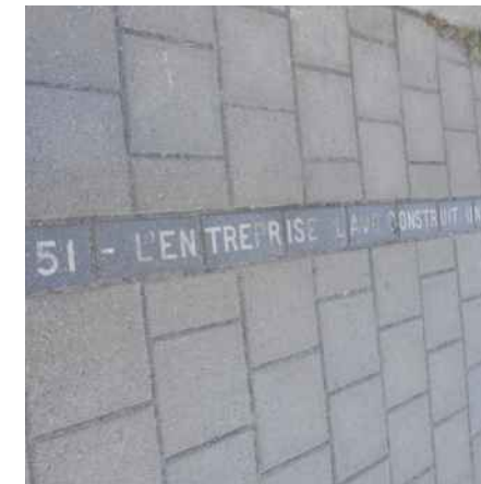
Pavés de béton préfabriqués insertions avec inscriptions commémoratives aux entrées couleurs antracite et gris régulier
