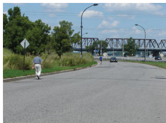
Absence de trottoirs, rue Carrie-Derick
