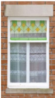
Fenêtre à guillotine  $\frac{1}{3}$  -  $\frac{2}{3}$  avec battants intérieurs (crémone)
