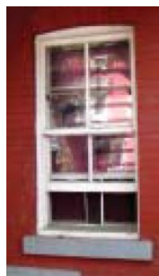
Fenêtre à guillotine \frac{1}{2} - \frac{1}{2} avec croisillon
