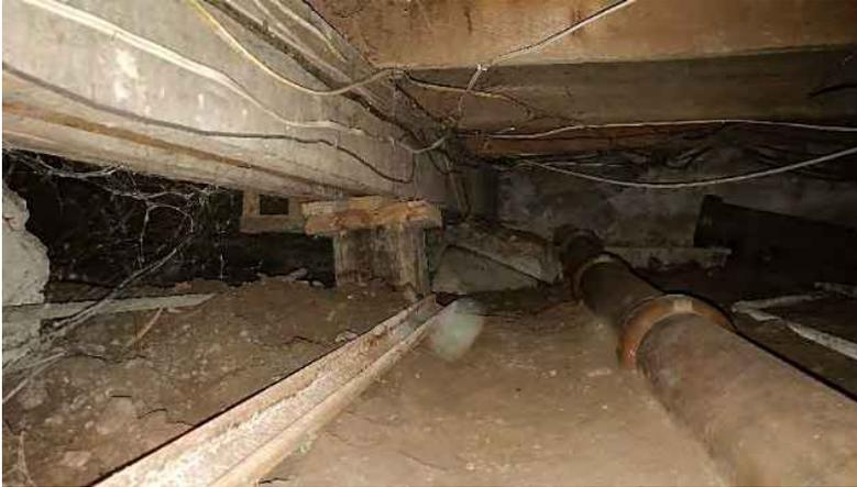
*Photo récente de notre vide sanitaire : on y voit une belle colonne en bois, la base à même la terre et qui se prend malheureusement pour la tour de Pise.*
