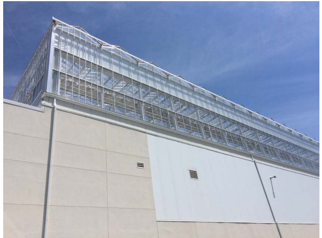
Serre sur un toit
