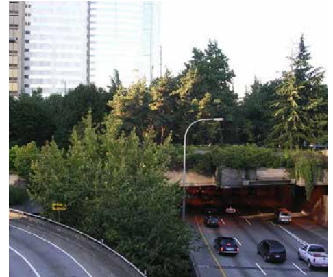
Exemple de verdissement d'une autoroute, Autoroute 5, Seattle, Washington
