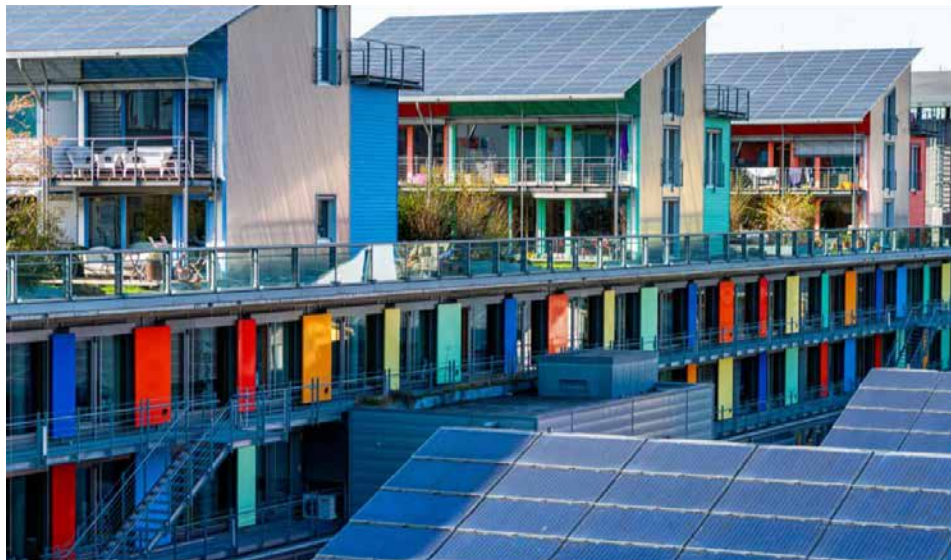
Exemple d'utilisation d'énergie solaire, Vauban Fribourg, Green City Times
