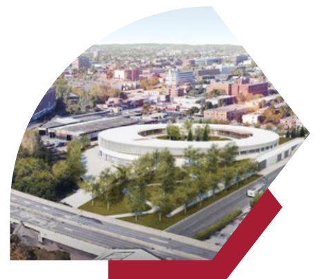
Centre de transport Bellechasse Crédit photo : stm.info
