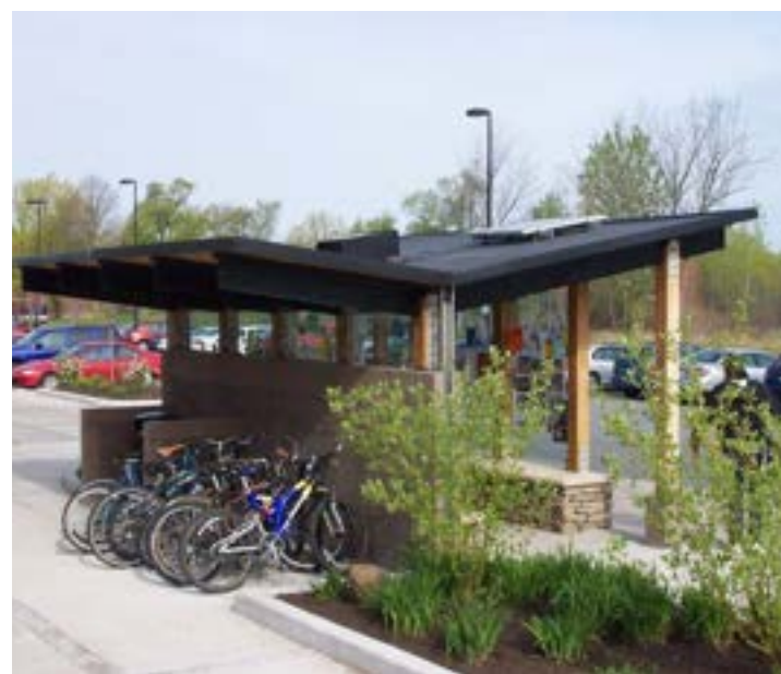
Fig. 300. Stationnement pour vélo abrité (Source: GFLRPC)
