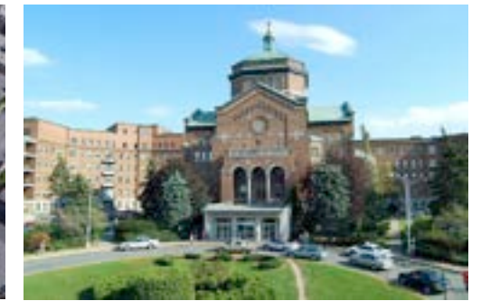
Fig. 54. Hôpital du Sacré-Coeur de Montréal (Source: Bouthillette Parizeau)
