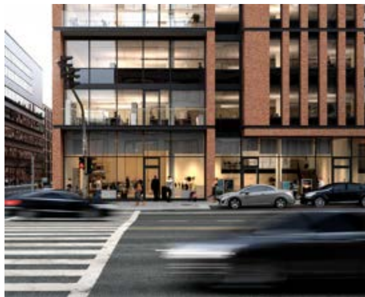
Fig. 266. Façade transparente en relation avec le domaine public, Hambourg, Allemagne (Source: GMP Architekten)
