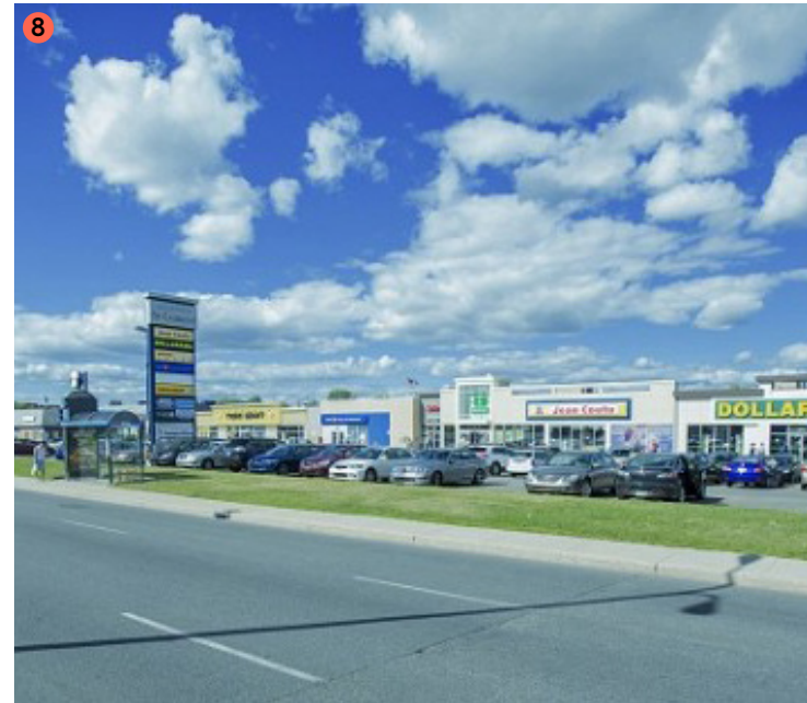
Fig. 11. Galerie Saint-Laurent, boulevard Marcel-Laurin (Source : Groupe Shapiro)
