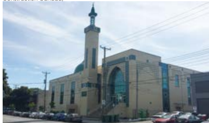
Fig. 222. Centre islamique du Québec (ICQ) implanté sur le chemin Laval à proximité de la rue Grenet (Source: Provencher Roy)
