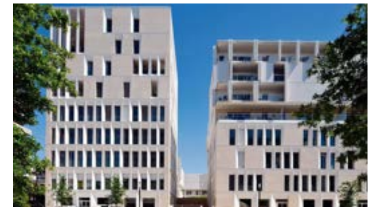
Fig. 261. Traitement architectural distinct selon les usages résidentiels et bureau d'un immeuble mixte, Lyon, France (Source: Vera et Associés architectes)
