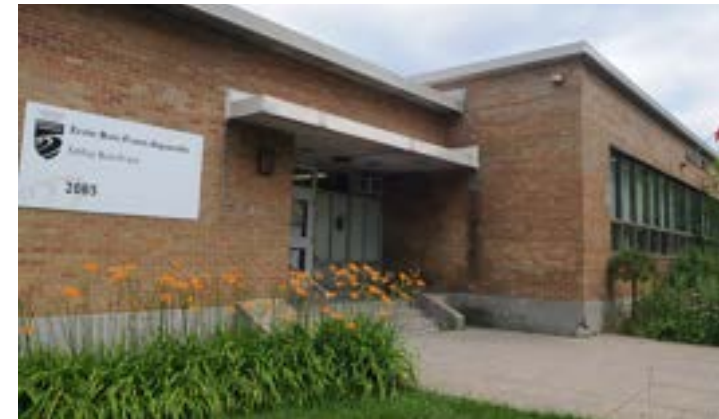
Fig. 225. École Bois-Franc-Aquarelle implantée sur la rue de Londres à proximité de la rue Grenet (Source: Écoles Saint-Laurent)
