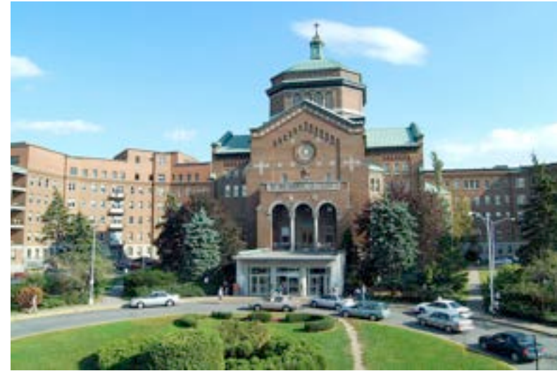
Fig. 70. Hôpital du Sacré-Coeur de Montréal (Source: Bouthillette Parizeau)
