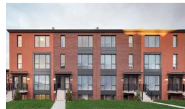
Fig. 249. Plex de 3 étages, Bois-Franc, Montréal (Source: Ecohabitation)
