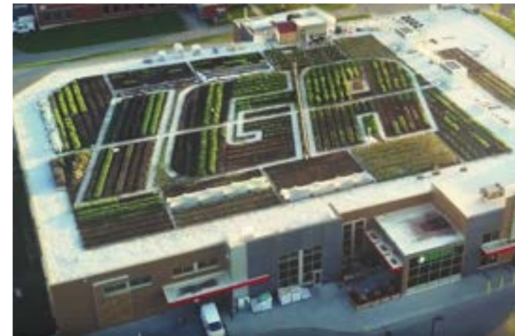
Fig. 190. Toiture commerciale où l'on pratique l'agriculture urbaine, Arrondissement Saint-Laurent, Montréal (Source: Centdegrés)
