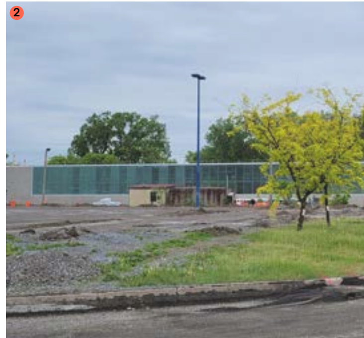
Fig. 5. Station du REM Bois-Franc en construction (Source : Groupe BC2)
