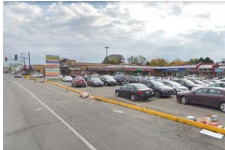
Fig. 65.Centre Cartierville (Source: Google)
