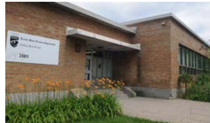
Fig. 225. École Bois-Franc-Aquarelle implantée sur la rue de Londres à proximité de la rue Grenet (Source: Écoles Saint-Laurent)
