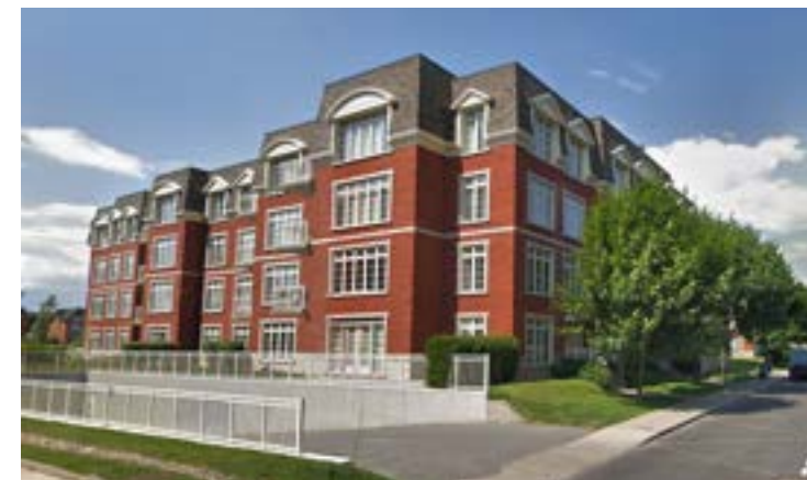
Fig. 112. Rue des Nations, Quartier Bois-Franc (Source: Google Maps, août 2018)
