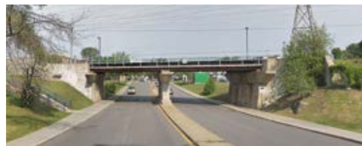
Fig. 88. Rue Grenet (Source: Streetview, Août 2018)
