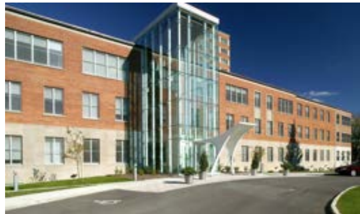
Fig. 221. Carrefour Providence implanté sur la propriété des Soeurs de la Providence aux abords de la rue Grenet (Source: ICB Construction Canada)
