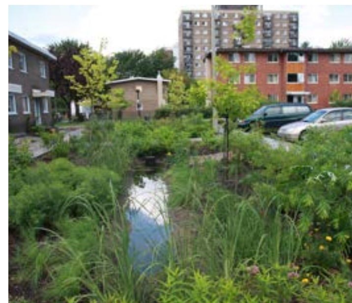
Fig. 301. Noue paysagère en bordure d'un stationnement de surface, Habitations Jeanne-Mance, Montréal (Source: Médiaterre)
