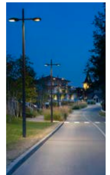
Fig. 173. Éclairage public (Source: SDEM50)
