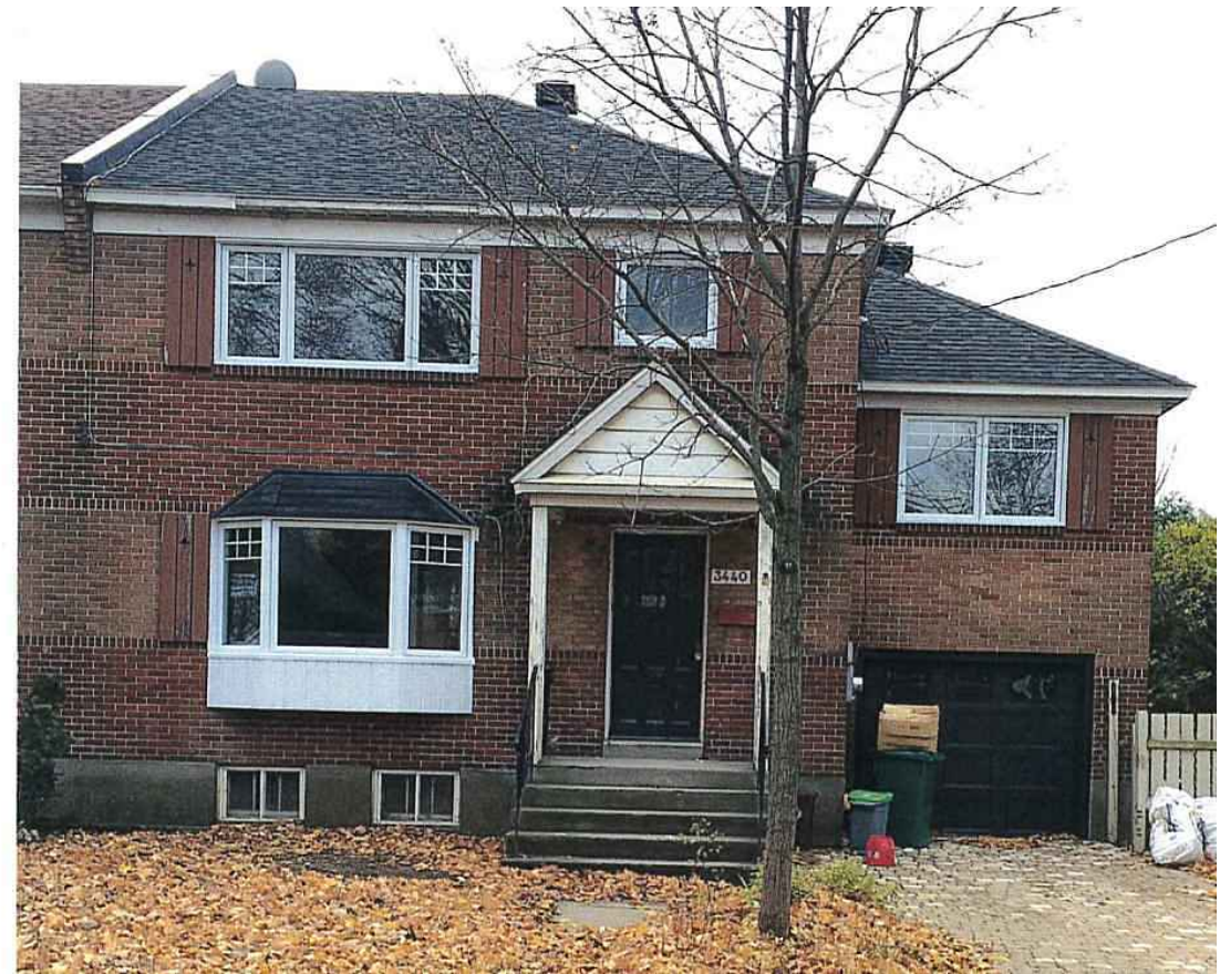
Fenêtre après les travaux
