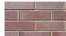
6 Maçonnerie de brique
