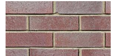
6 Maçonnerie de brique
