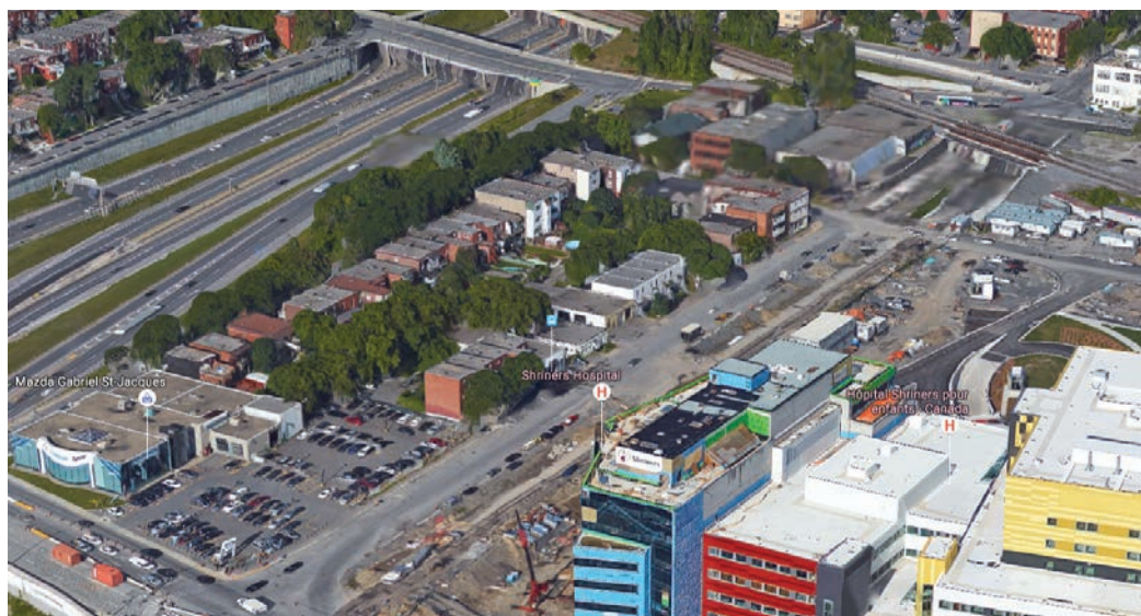
Fig. 13 Vue aérienne du boulevard Décarie, face au CUSM [Source : Google maps]
