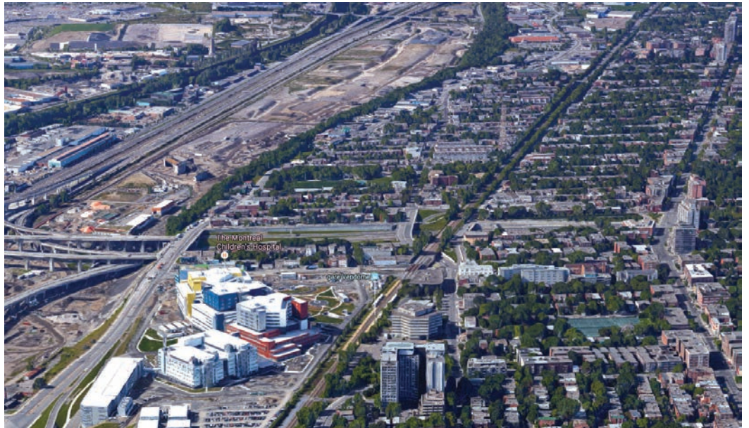
Fig. 24 Secteur Saint-Raymond et les abords du CUSM [Source : Google maps]
