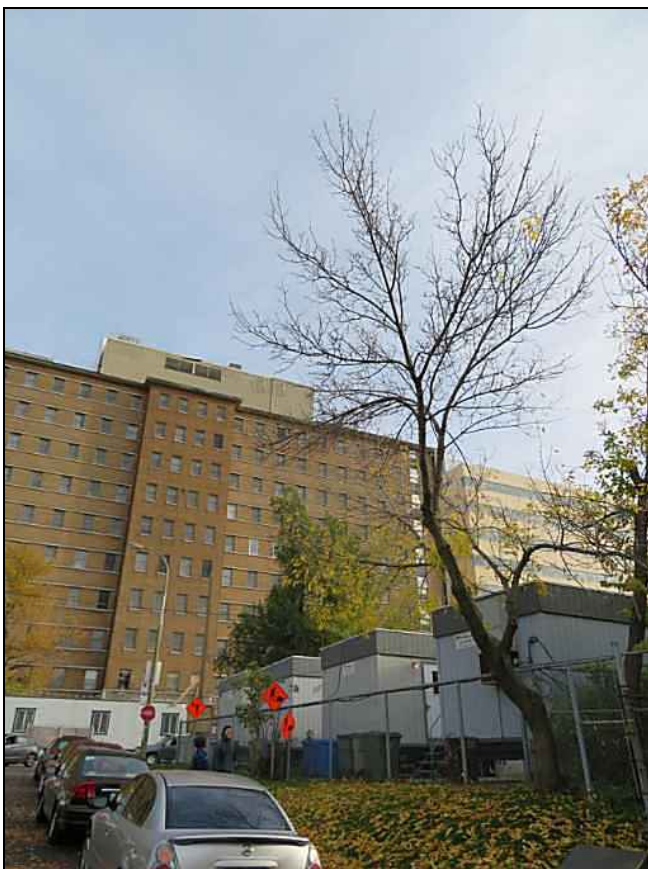
Photo 1 arbre #1 Vue générale de l'arbre et de son inclinaison d'environ 30 degrés
