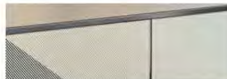
GARDE-CORPS 01 : Verre sérigraphié blanc avec points transparent
