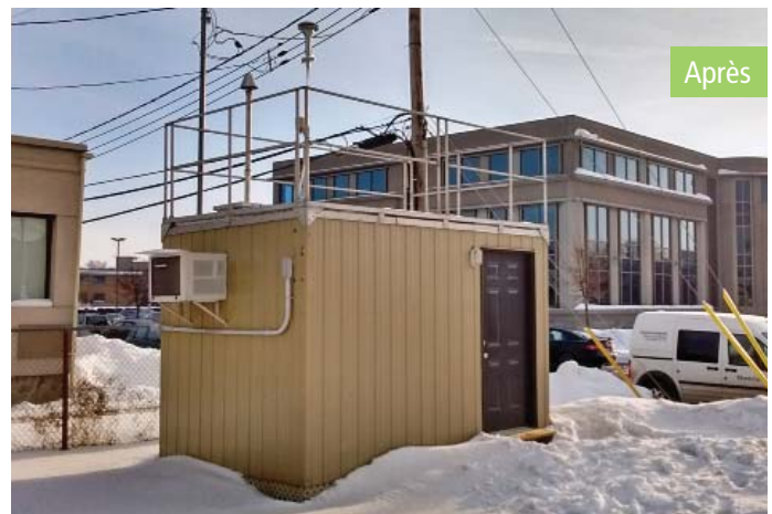
Remplacement de la station de l'échangeur Décarie (28)
