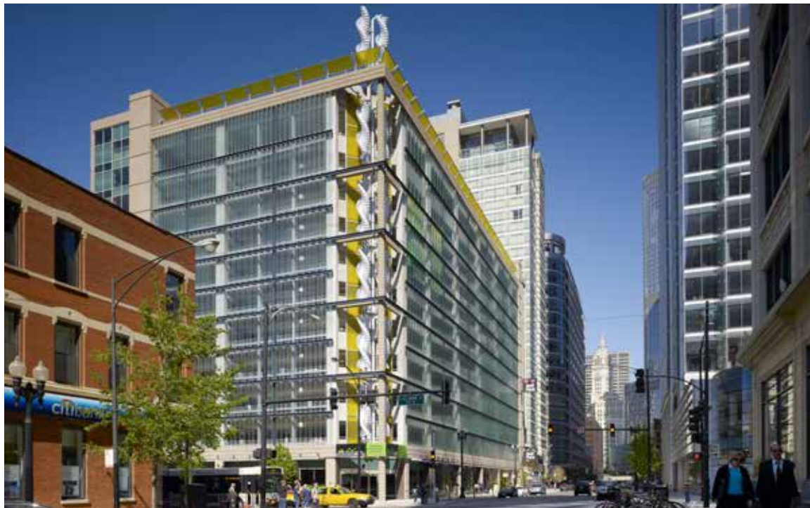
Crédit : Walker Parking Consultants
