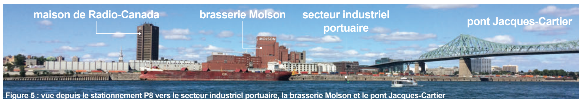
Vue depuis le stationnement P8 vers le secteur industriel portuaire, la brasserie Molson et le pont Jacques-Cartier
