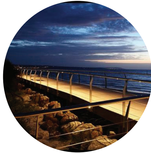
Figure 48 : exemple d'ambiance lumineuse recommandée pour les passerelles de la promenade riveraine. Carrum Foreshore, Melbourne, Australia
