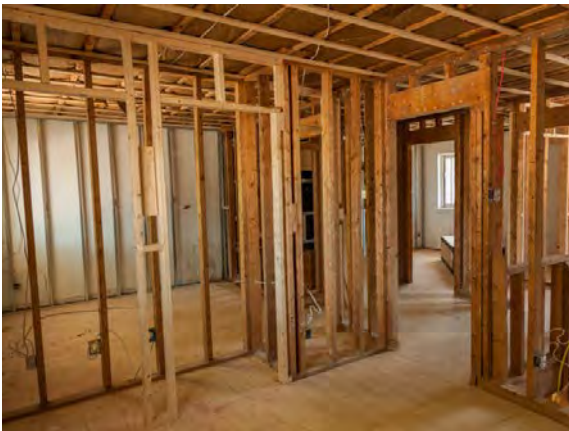
Un logement en travaux de modernisation
