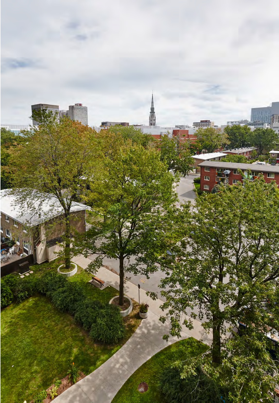
Vue aérienne (sud-est) des Habitations Jeanne-Mance
