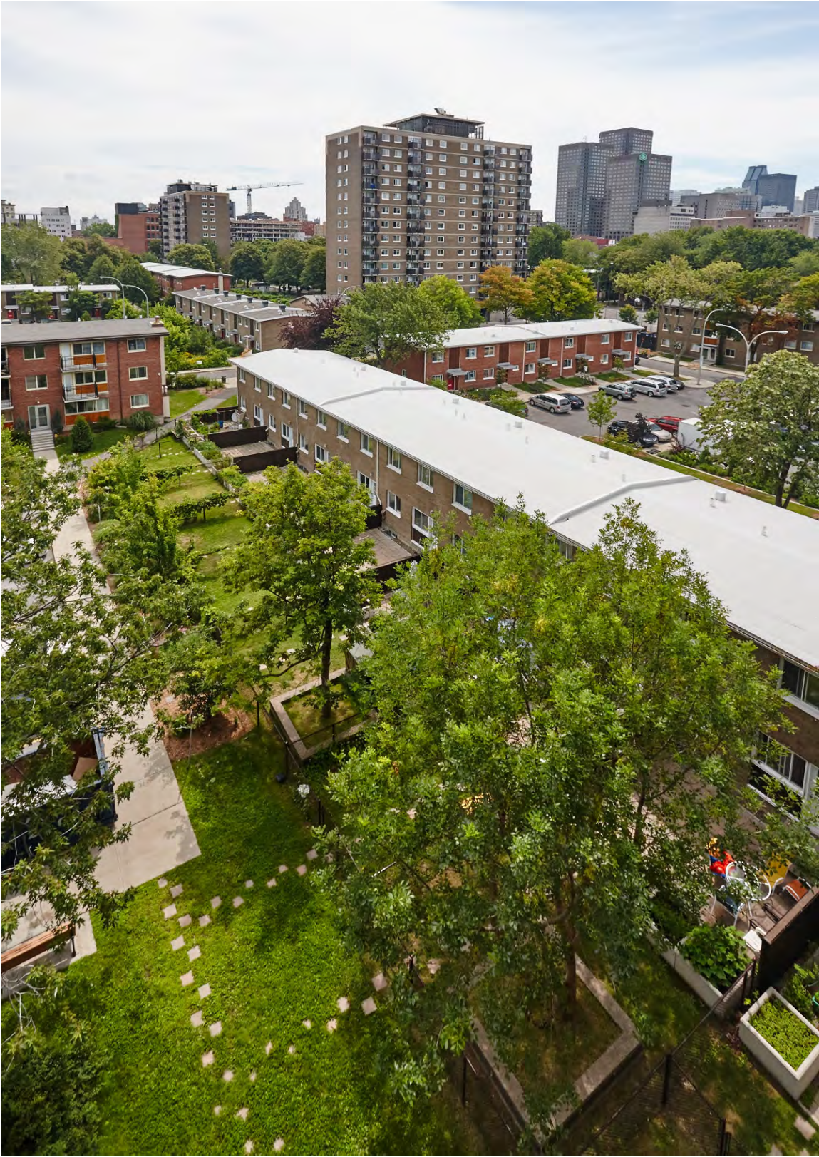
Vue aérienne (sud-ouest) des Habitations Jeanne-Mance
