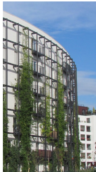
FORT D'ISSY, 329 LOGEMENTS, ISSY-LES- MOULINEAUX - FRANCE
