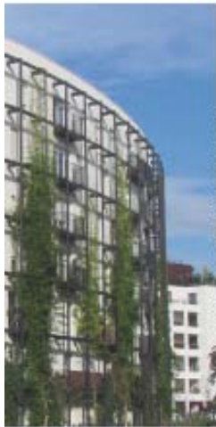
FORT D'ISSY - 329 LOGEMENTS - ISSY-LES-MOULINEAUX - FRANCE
