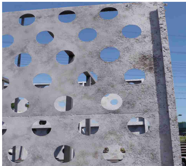
Après préparation de surface
