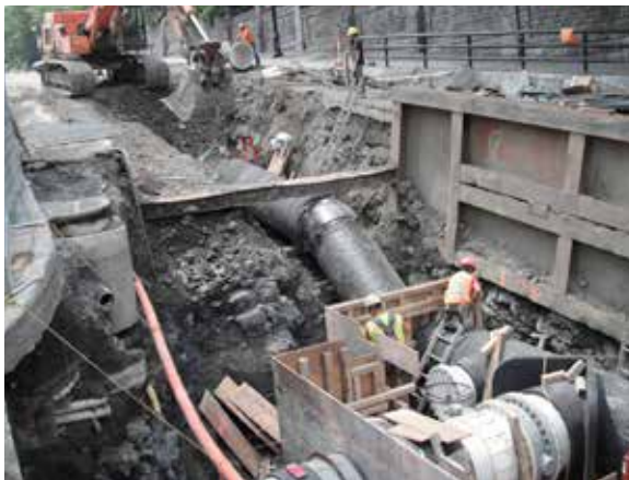
Remplacement de conduites primaires sur McTavish
