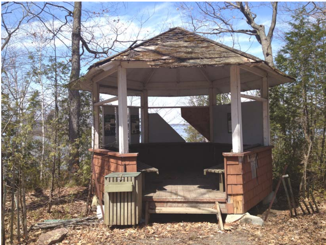
Vue en façade de l'observatoire existant. (Photo printemps 2013)
