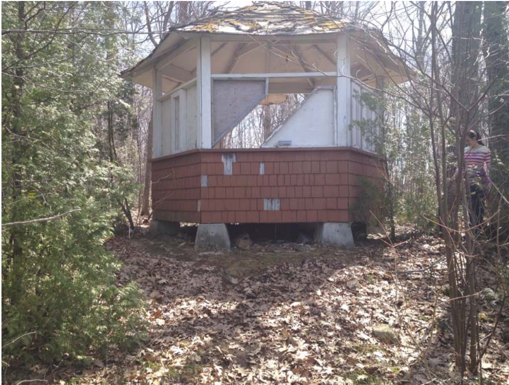
Vue de l'arrière de l'observatoire existant. (Photo printemps 2013)
