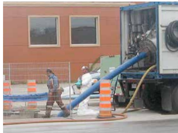
Gainage d'une conduite d'aqueduc
