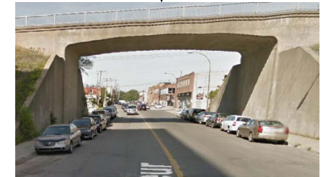
Pont ferroviaire du CN : Rue Meilleur Entre rue Louvain et rue Port-Royal
