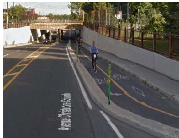
Pont ferroviaire du CP : Av. Christophe-Colomb Entre boul. Rosemont et rue St-Grégoire
