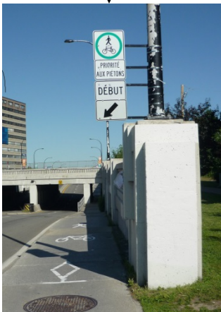
Pont ferroviaire du CP : Rue Saint-Denis Entre boul. Rosemont et Av. du Carmel
