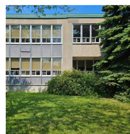
État actuel des panneaux d'amiante
