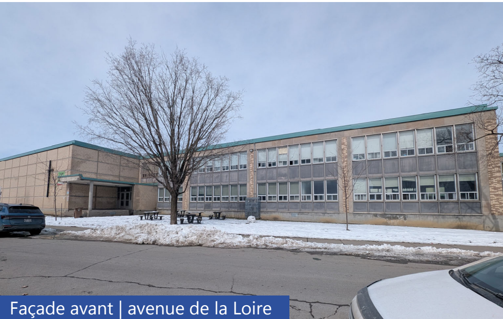
Façade avant | boulevard Wilfrid Pelletier
