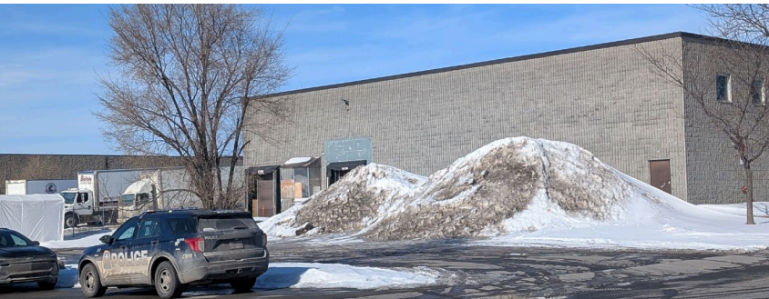
Espace d'entreposage de camions et quais de chargement CCU 2 mars 2026 - 9900, boulevard Ray-Lawson
