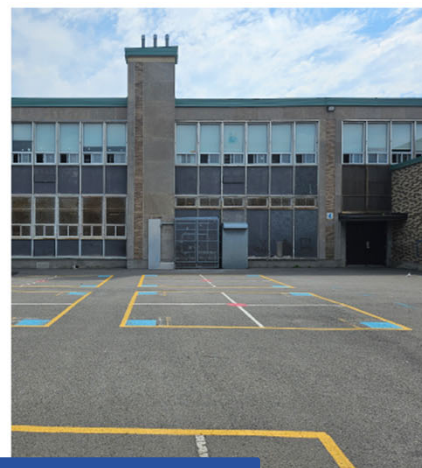
État actuel des panneaux d'amiante
