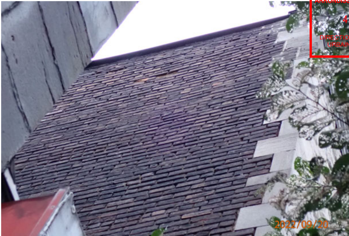
Mur latéral entre l'église et le 94 Sainte-Catherine Est montrant la brique de couleur d'origine endommagée et effritée.
