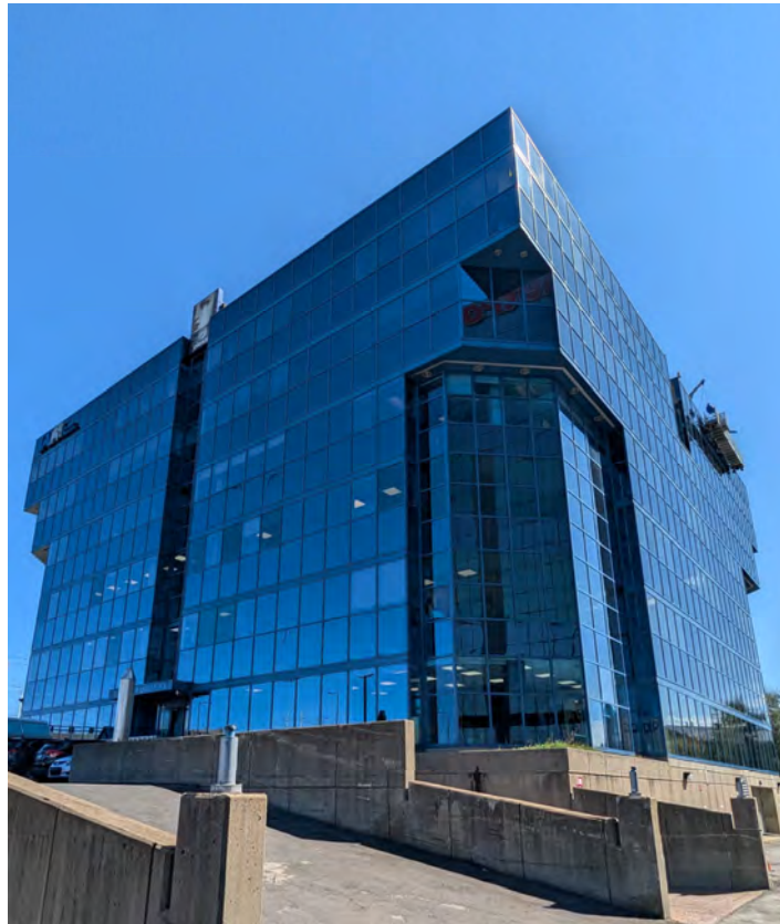
Façades latérale gauche et Façade arrière | boul. Métropolitain E
