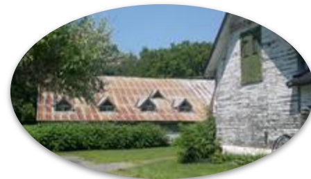
Sauvegarde du patrimoine
