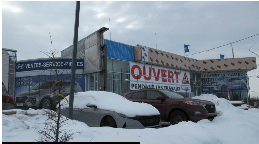
7020, boul. Henri-Bourassa E Bâtiment visé par l'agrandissement et la rénovation de façades.
