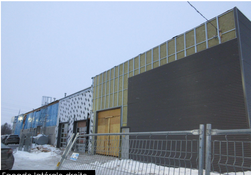
Façade latérale droite
