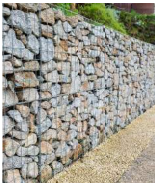
MURET DE GABION
