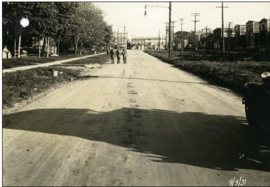
Photographie de 1931 du boulevard Décarie, proche du chemin Queen Mary.
