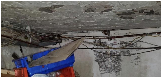
Photo 82 – Murs de fondation
