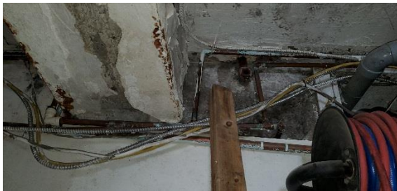
Photo 72- Dalle et poutres en béton - RDC
