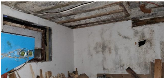
Photo 86 – Murs de fondation
