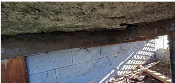
Photo 34 – Escalier Façade Ouest
