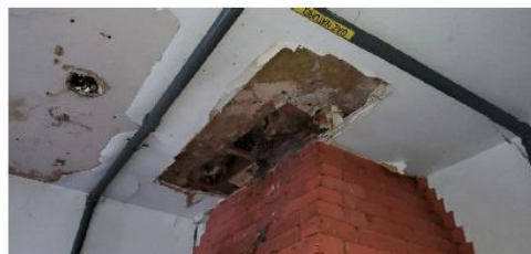
Photo 45 – Infiltration d'eau
