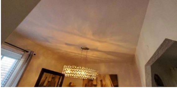
Allure du logement au 2 e étage du 5841. Source : D.L. Turner Consultants inc. p.13.
