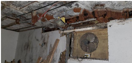
Photo 84 – Murs de fondation
