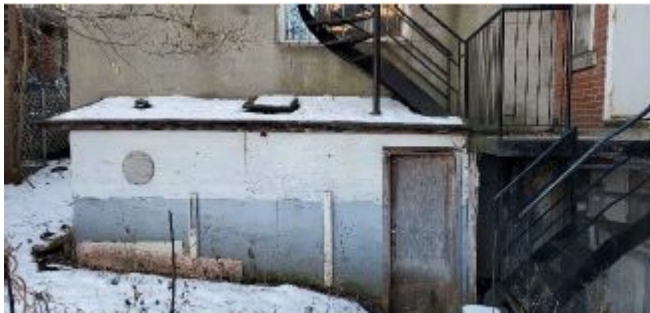
Photo 38 – Remise en bois
