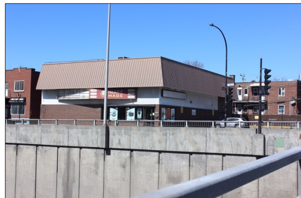
Vue en biais de l'immeuble 5805-5807 boulevard Décarie à partir de viaduc de l'avenue Bourret.
