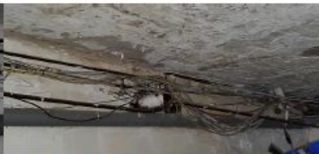
Photo 81 - Murs de fondation
