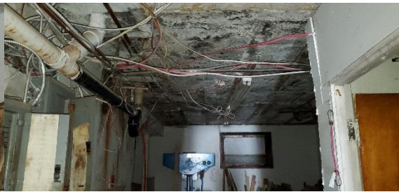
Photo 67 – Dalle et poutres en béton - RDC
