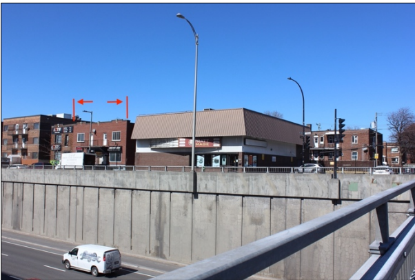
Façades principales des immeubles 5837-5845 boulevard Décarie à partir du viaduc de l'avenue Bourret.
