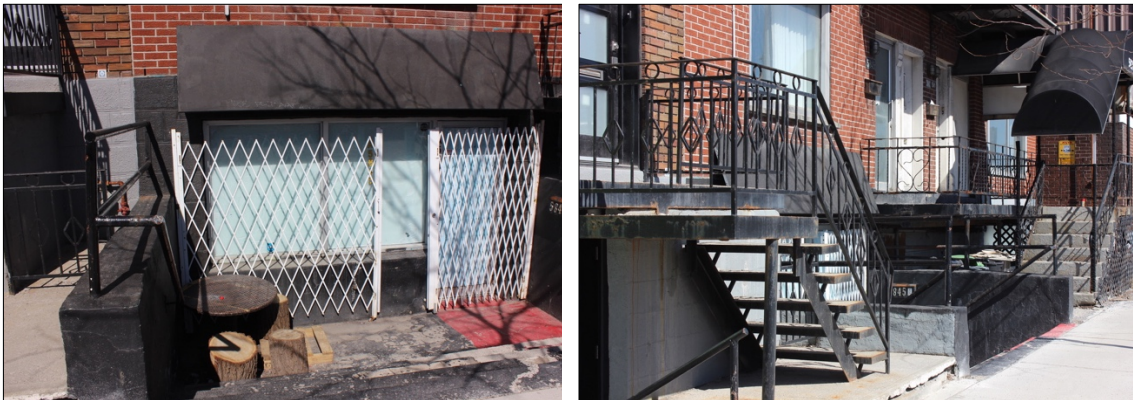
Traitement des cours anglaises des 5837-5845, boulevard Décarie.
