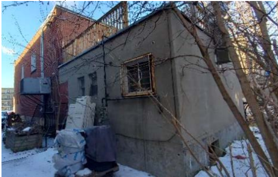
Les façades Sud et Est du 5839-5841 et de son extension. Source : D.L. Turner Consultants inc. p.4.
