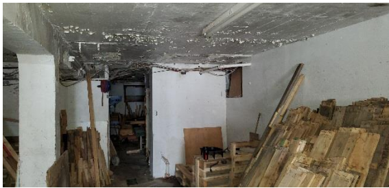
Photo 66- Dalle et poutres en béton - RDC
