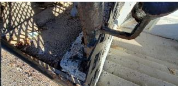
Photo 35 – Escalier Façade Ouest
