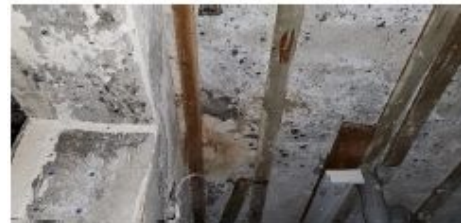
Photo 70- Dalle et poutres en béton - RDC
