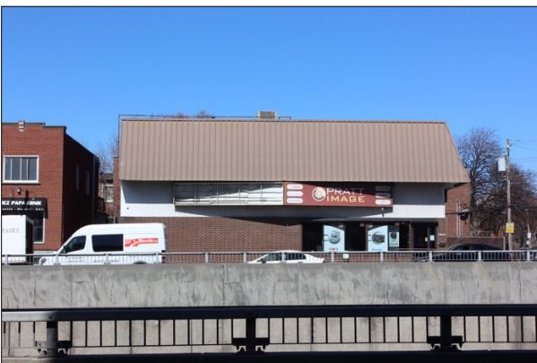
Façade principale de l'immeuble 5805-5807 boulevard Décarie à partir de la rive ouest du boulevard.
