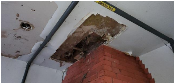
Photo 45 – Infiltration d'eau
