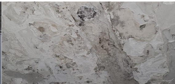
Photo 69 – Dalle et poutres en béton – RDC
