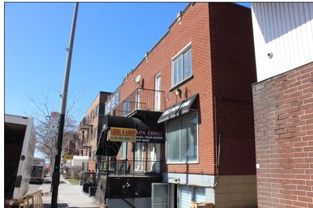
Photographie des immeubles du 5837-5845, boulevard Décarie.
