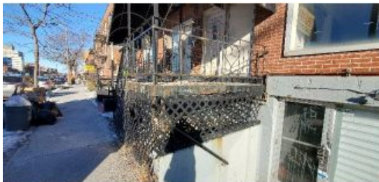
Photo 30 – Escalier Façade Ouest
