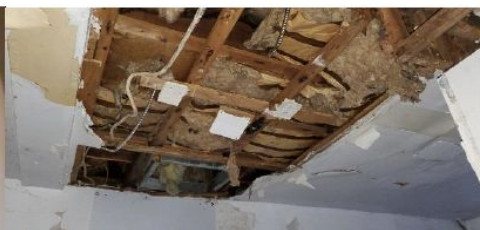
Photo 44 – Infiltration d'eau
