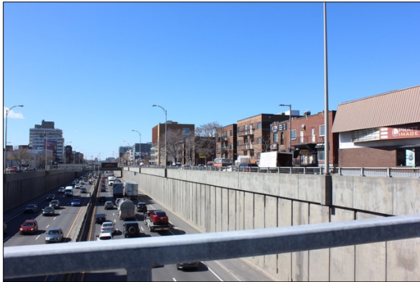
A – Vue vers la rive est, direction nord, du boulevard Décarie, à partir de la passerelle de l'avenue Bourret.
