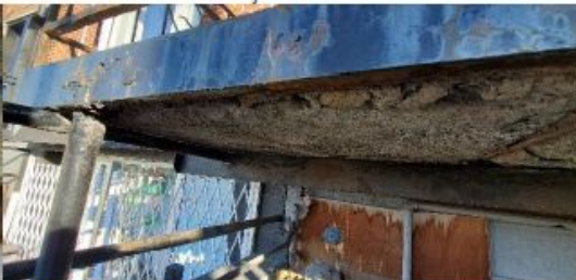
Photo 33 – Escalier Façade Ouest
