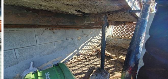
Photo 31 – Escalier Façade Ouest
