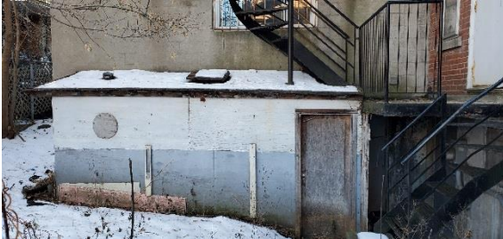
Photo 38 – Remise en bois
