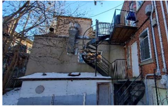
Les façades Est du 5839-5845 et la façade Nord de l'extension. Source : D.L. Turner Consultants inc. p.4.
