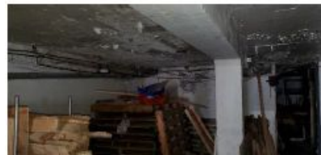
Photo 68- Dalle et poutres en béton - RDC
