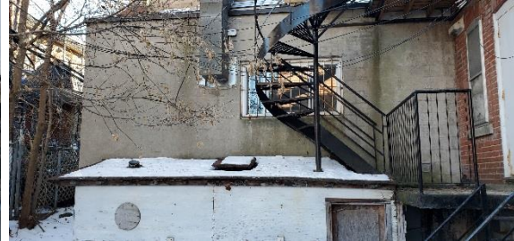
Photo 39 – Remise en bois
