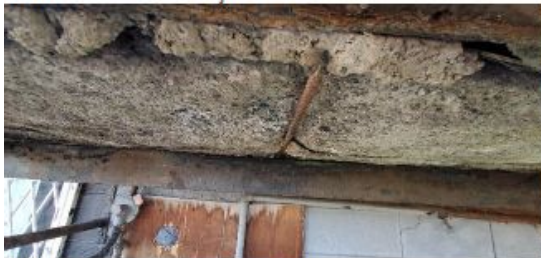
Photo 32 – Escalier Façade Ouest
