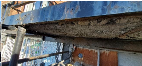
Photo 37 – Escalier Façade Ouest
