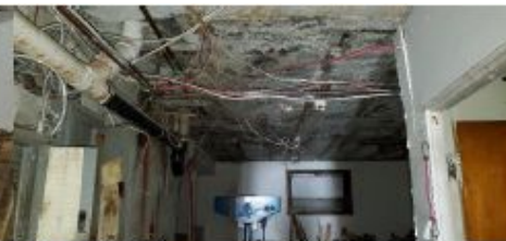
Photo 67 - Dalle et poutres en béton - RDC
