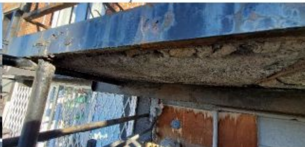
Photo 37 – Escalier Façade Ouest
