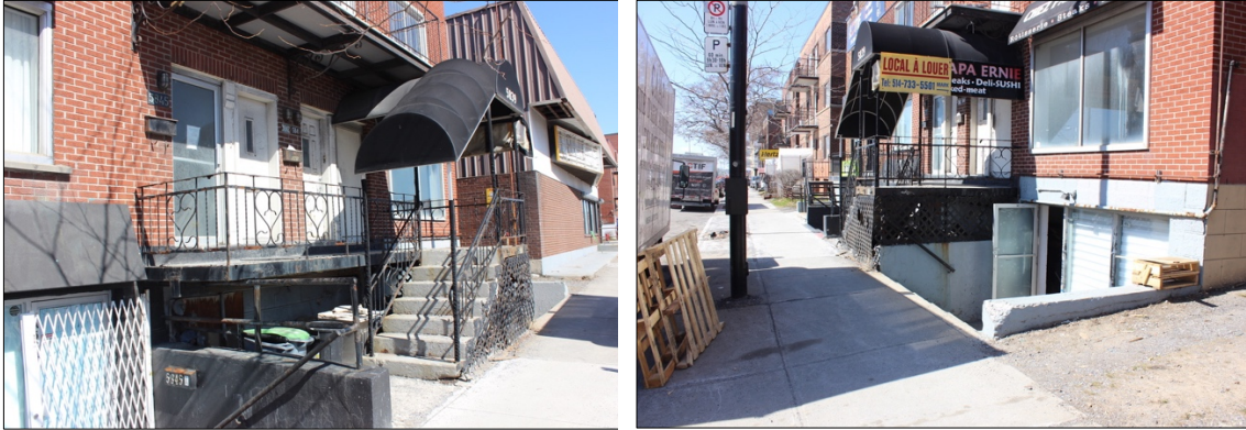
Traitement des cours anglaises des 5837-5845, boulevard Décarie.
