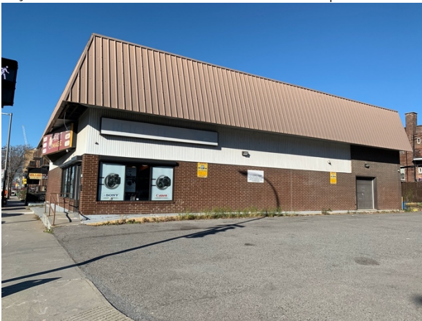
Façades Sud et Ouest.
