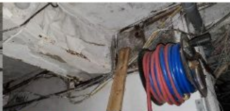
Photo 83 - Murs de fondation
