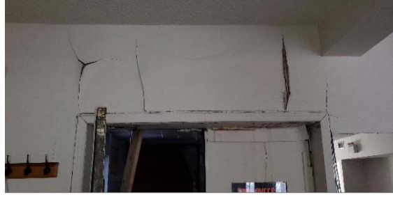
Allure du logement au 2 e étage du 5845. Source : D.L. Turner Consultants inc. p.17.
