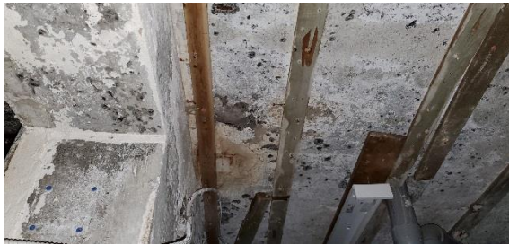
Photo 70- Dalle et poutres en béton - RDC
