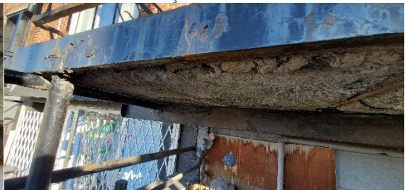
Photo 33 – Escalier Façade Ouest
