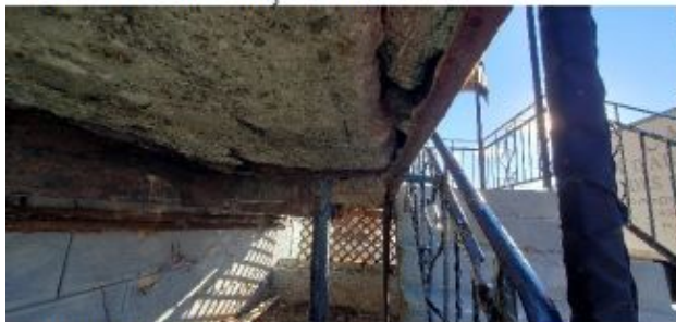
Photo 36 – Escalier Façade Ouest
