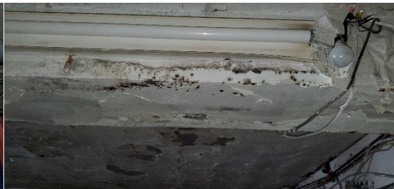
Photo 73 – Dalle et poutres en béton - RDC
