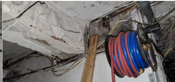
Photo 83 – Murs de fondation
