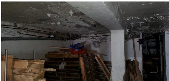
Photo 68- Dalle et poutres en béton - RDC
