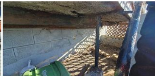
Photo 31 – Escalier Façade Ouest
