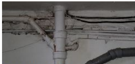
Photo 80 - Murs de fondation
