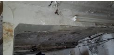
Photo 71 - Dalle et poutres en béton - RDC
