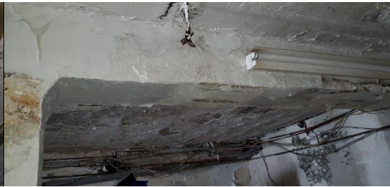
Photo 71 – Dalle et poutres en béton – RDC
