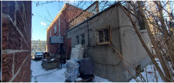
c) Façade sud et est
