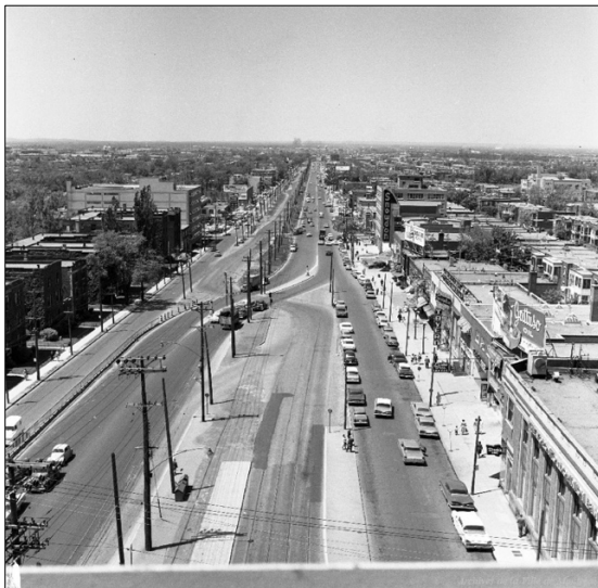
Vue vers le nord du boulevard Décarie, depuis l'intersection du chemin Queen-Mary. 7 juin 1961.
