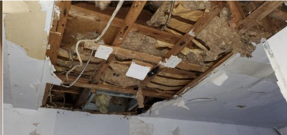
Photo 44 – Infiltration d'eau
