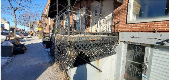
Photo 30 – Escalier Façade Ouest
