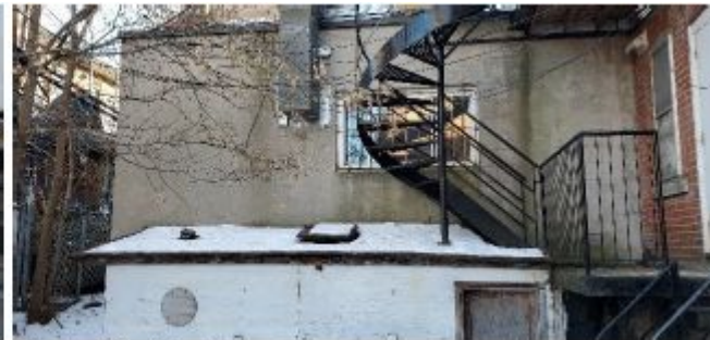
Photo 39 – Remise en bois
