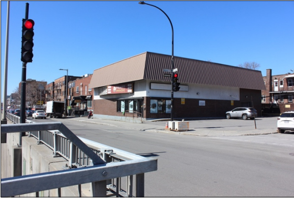
Vue en biais de l'immeuble 5805-5807 boulevard Décarie à partir de viaduc de l'avenue Bourret.
