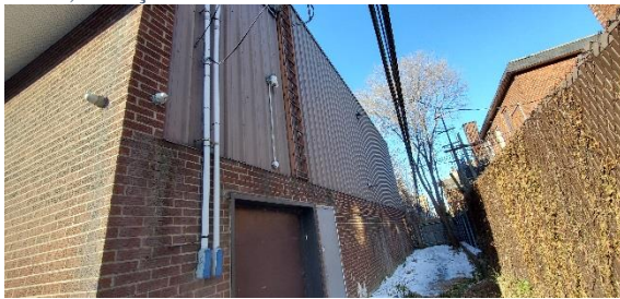
b) Façade est
