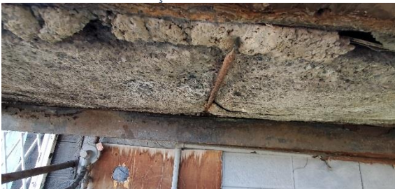
Photo 32 – Escalier Façade Ouest
