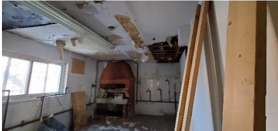
Photo 43 – Infiltration d'eau
