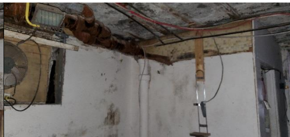
Photo 87 – Murs de fondation
