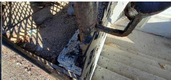
Photo 35 – Escalier Façade Ouest
