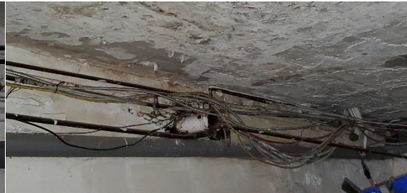
Photo 81 – Murs de fondation
