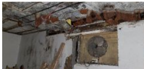
Photo 84 - Murs de fondation
