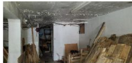
Photo 66- Dalle et poutres en béton - RDC
