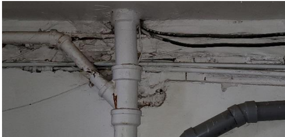
Photo 80 – Murs de fondation
