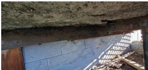
Photo 34 – Escalier Façade Ouest
