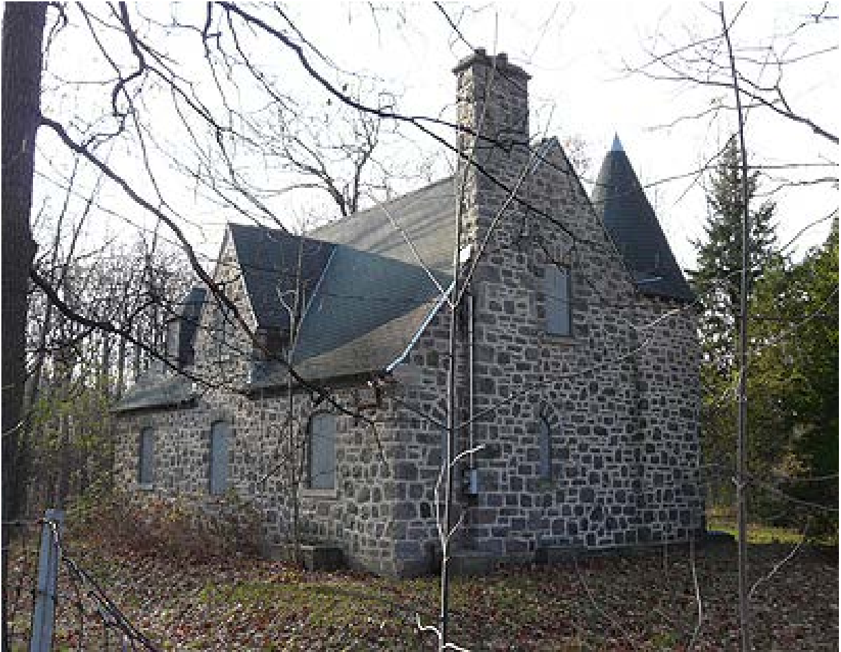
Maison du chauffeur, située tout près du boulevard Gouin (Ville de Montréal)
