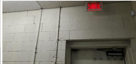
Photo 12- Fissures Mur bloc béton
