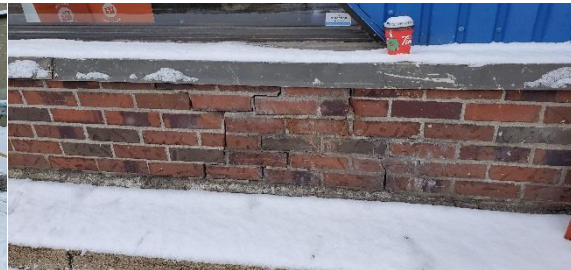
Photo 4- fissures muret de briques
