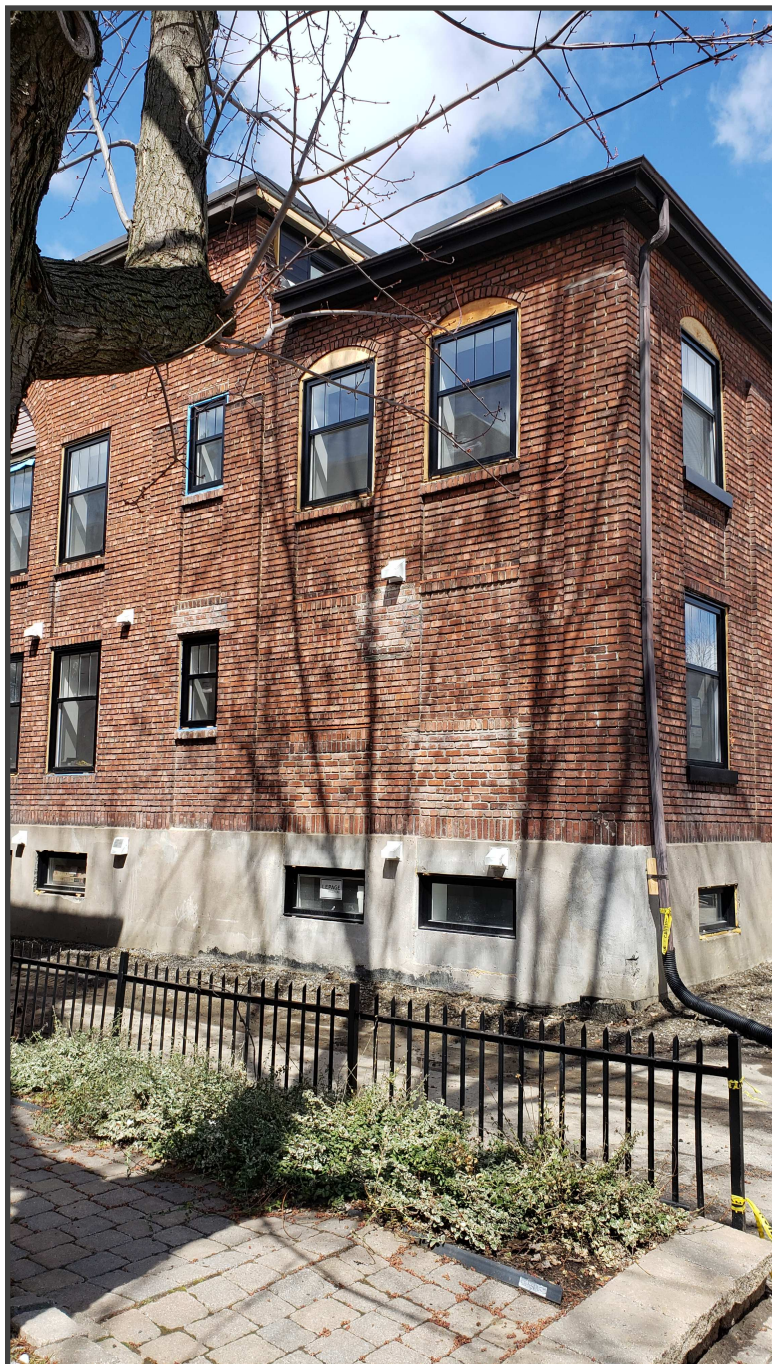
Élévation latérale - côté ruelle (aperçu général)
