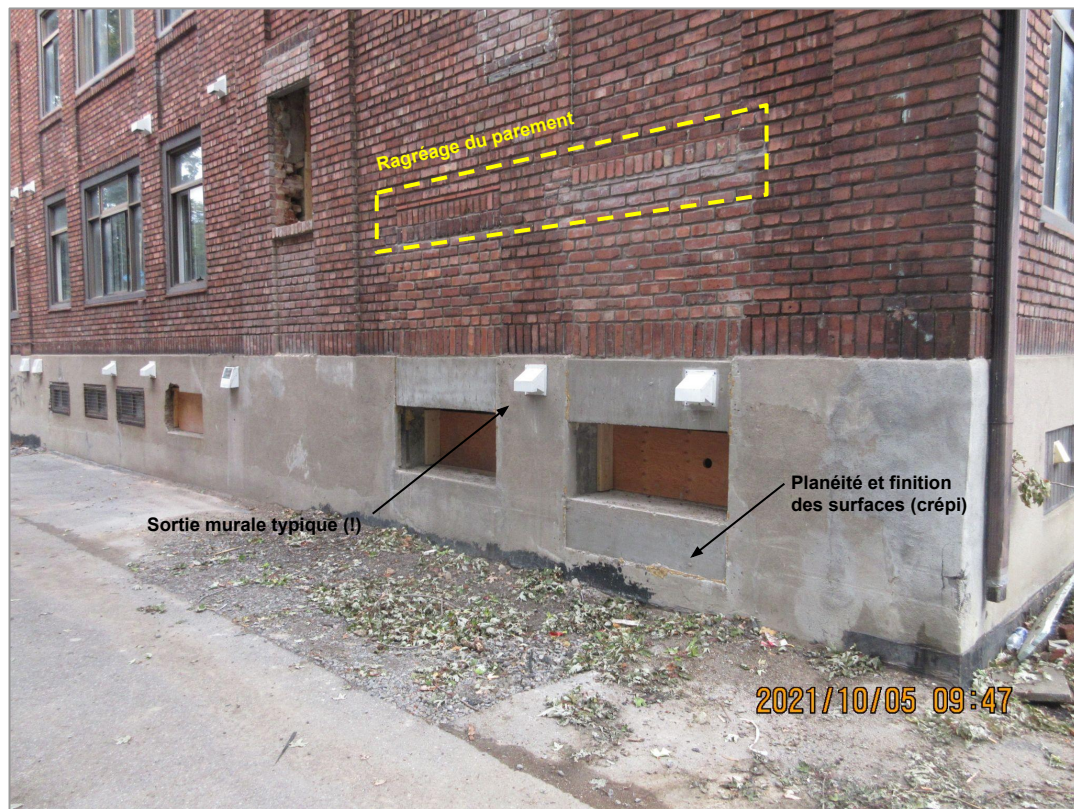
Déficiences / irrégularités relevées au chantier
