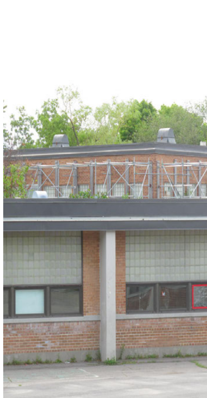
Echafaudages temporaires pour gymnase existant.
