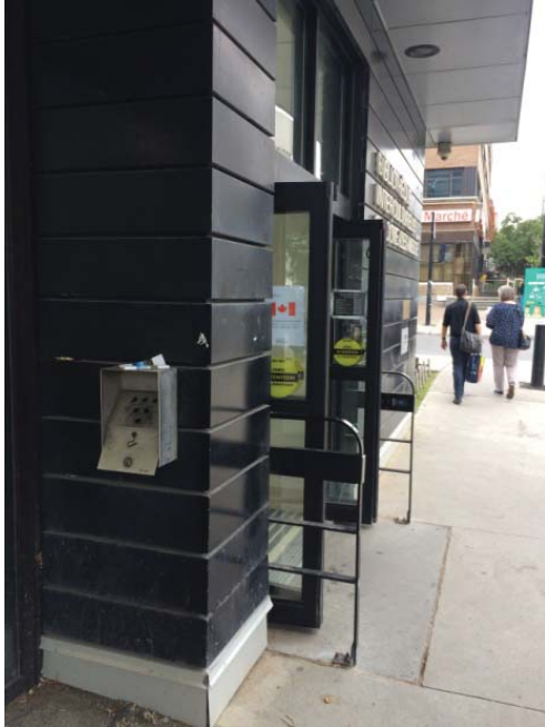
A Porte d'entrée actuelle de la bibliothèque
