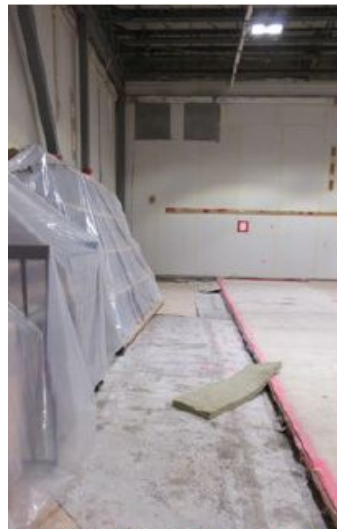
Photo 47 – Revêtement de plancher du gymnase Enlevé pour permettre pose des colonnes et contreventements
