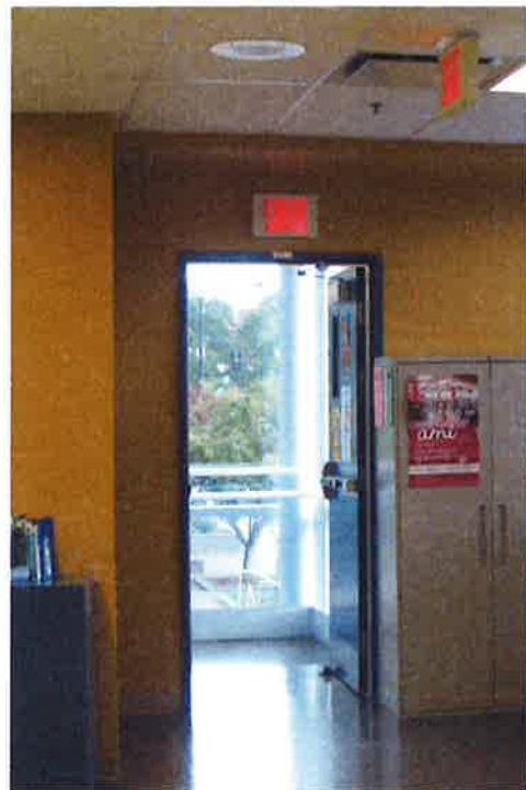
Photo 2- Porte au 2 e étage
