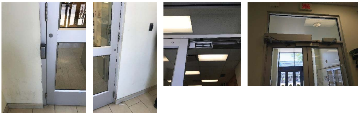
Figure 4 - Mécanismes d'accès de la porte intérieure
