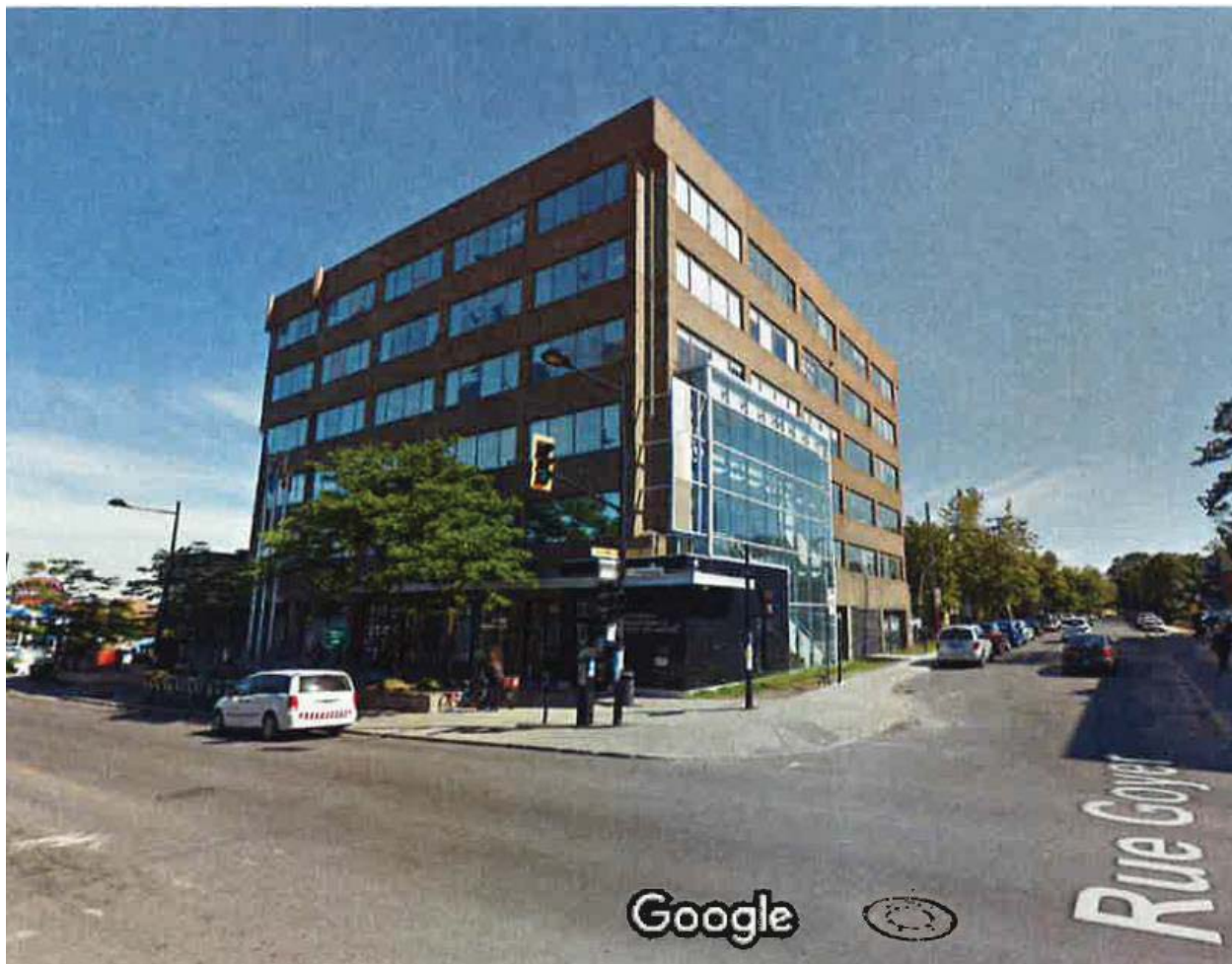
Figure 1 : Façades au coin du Chemin de la Côte-des-Neiges et de la rue Gohier montrant l'escalier d'issue sur la rue Gohier.
