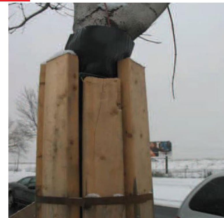
PLANCHE DE BOIS ET REVÊTEMENT MATELASSÉ SUR LE TRONC
