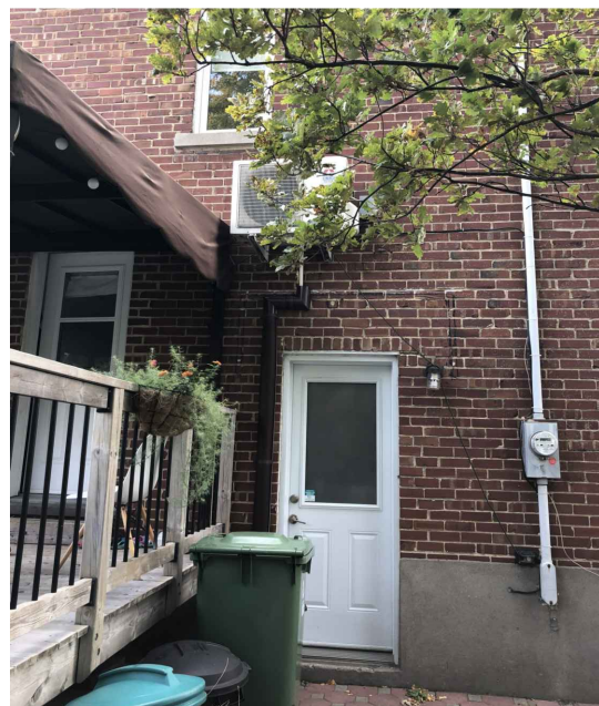
P5 - Façade latérale
