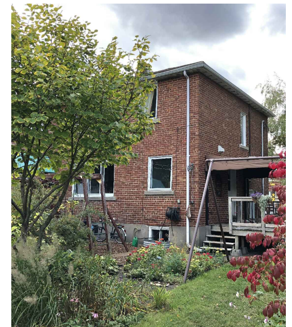
P9 - Vue générale de la cour arrière
