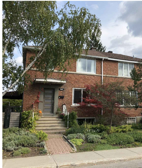
P1 - Façade avant
