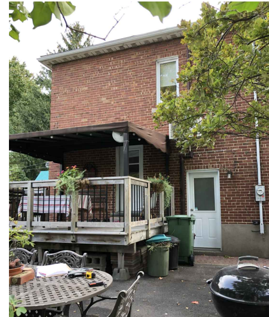
P3 - Façade latérale
