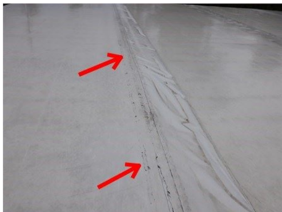
Exemple sur la toiture
