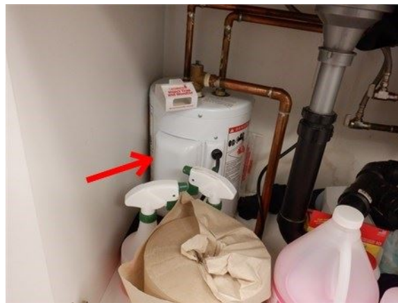
Sous l'évier - Salle de repos arrière droit
