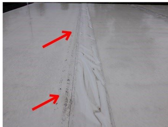
Exemple sur la toiture
