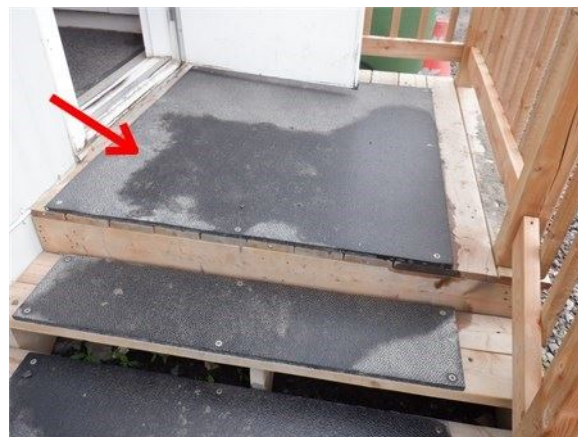
Exemple sur un balcon
