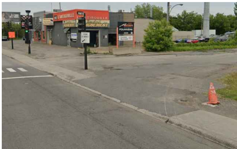
Photo 1 Accès nord – Feux de circulation non protégés
