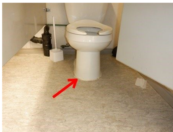
Exemple au pourtour d'une toilette
