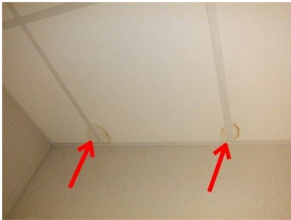
Plafond - Placard des chauffe-eaux
