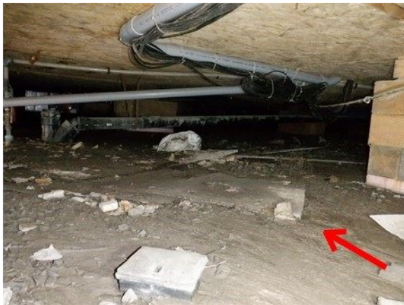
Exemple sous le bâtiment
