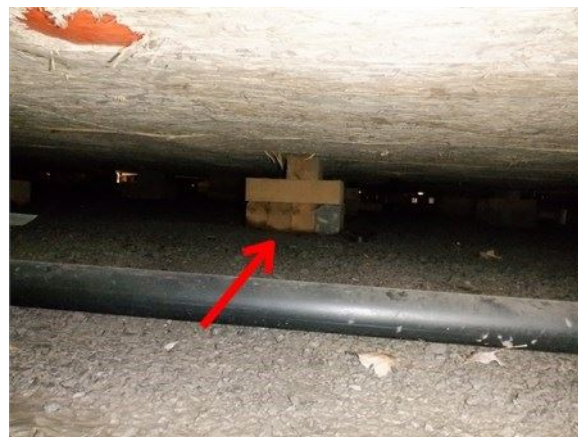
Sous le bâtiment
