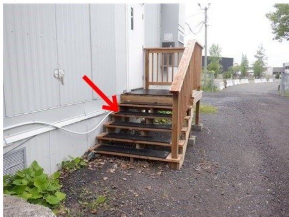
Exemple sur un balcon
