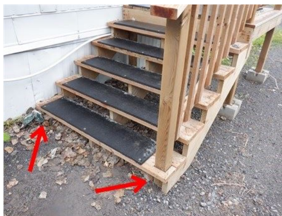
Exemple à la base de l'escalier
