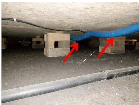
Dans le vide sanitaire/Sous le bâtiment
