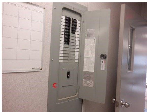
Corridor arrière centre
