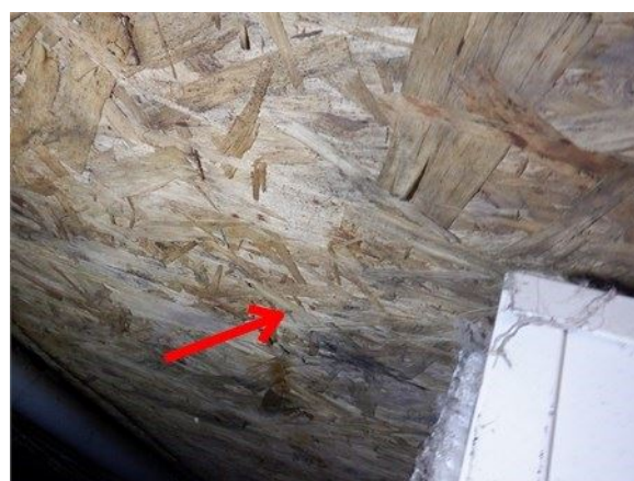
Exemple sous le bâtiment
