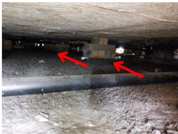
Sous le bâtiment - Vide sanitaire
