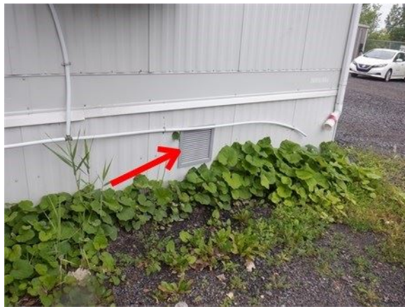
Pourtour des trappes extérieures
