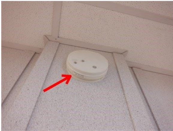
Corridor arrière centre
