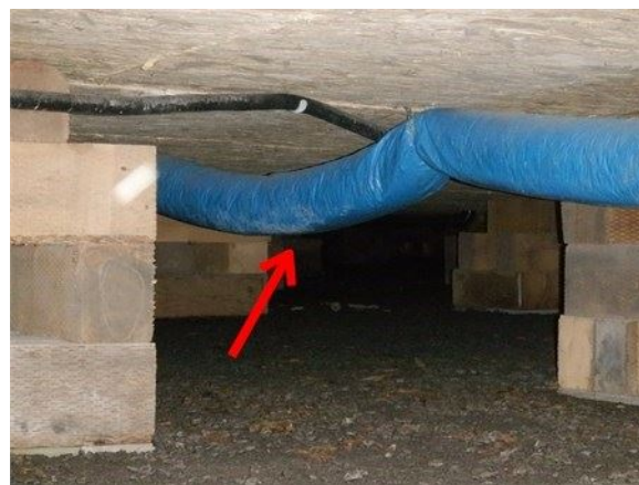
Dans le vide sanitaire/Sous le bâtiment
