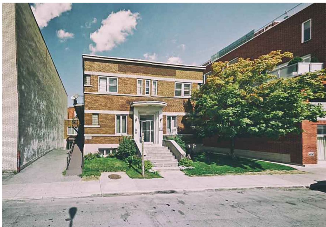
1. Façade avant à partir du Boulevard Saint-Laurent
