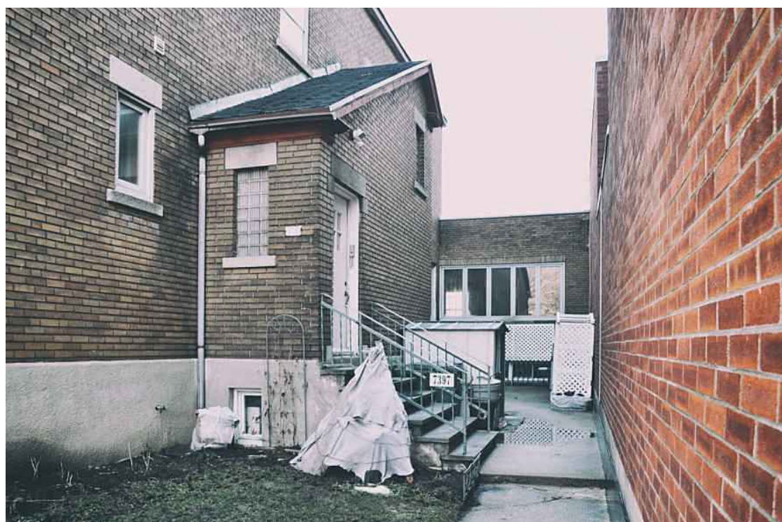
3. Façade latérale (Droite) à partir St-Laurent
