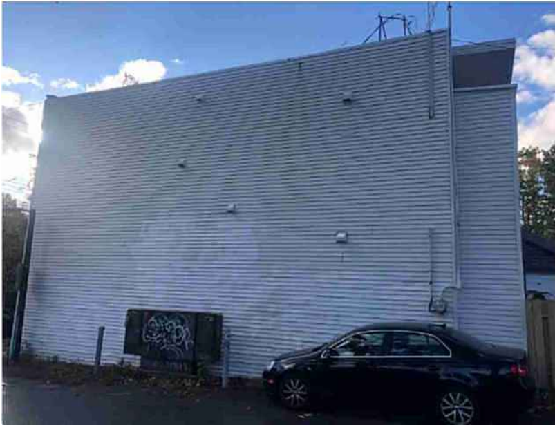
Le mur avant
