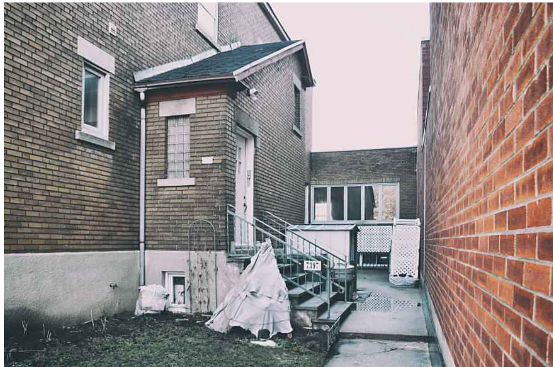
3. Façade latérale (Droite) à partir St-Laurent
