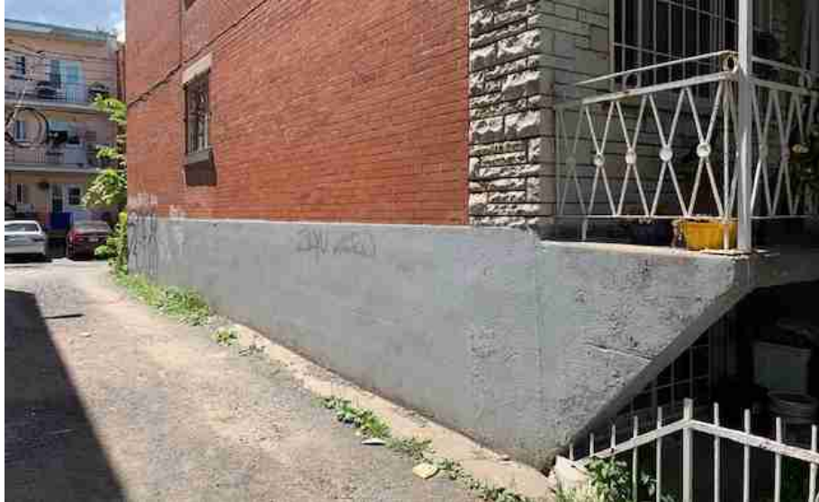
Le mur avant
