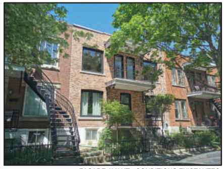
FAÇADE AVANT - CONDITIONS EXISTANTES
