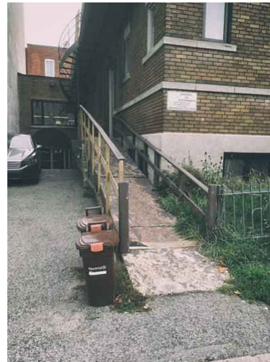
4. Façade latérale (Gauche) à partir St-Laurent
