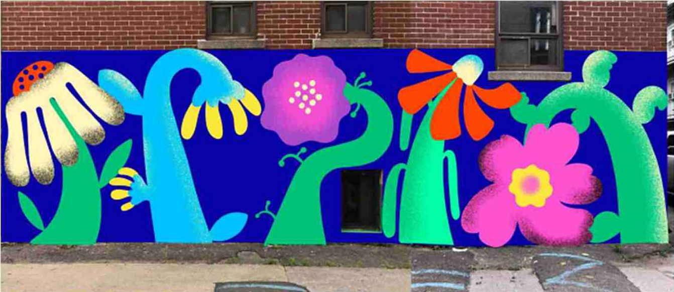
Le mur après
