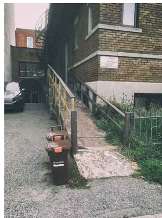
4. Façade latérale (Gauche) à partir St-Laurent
