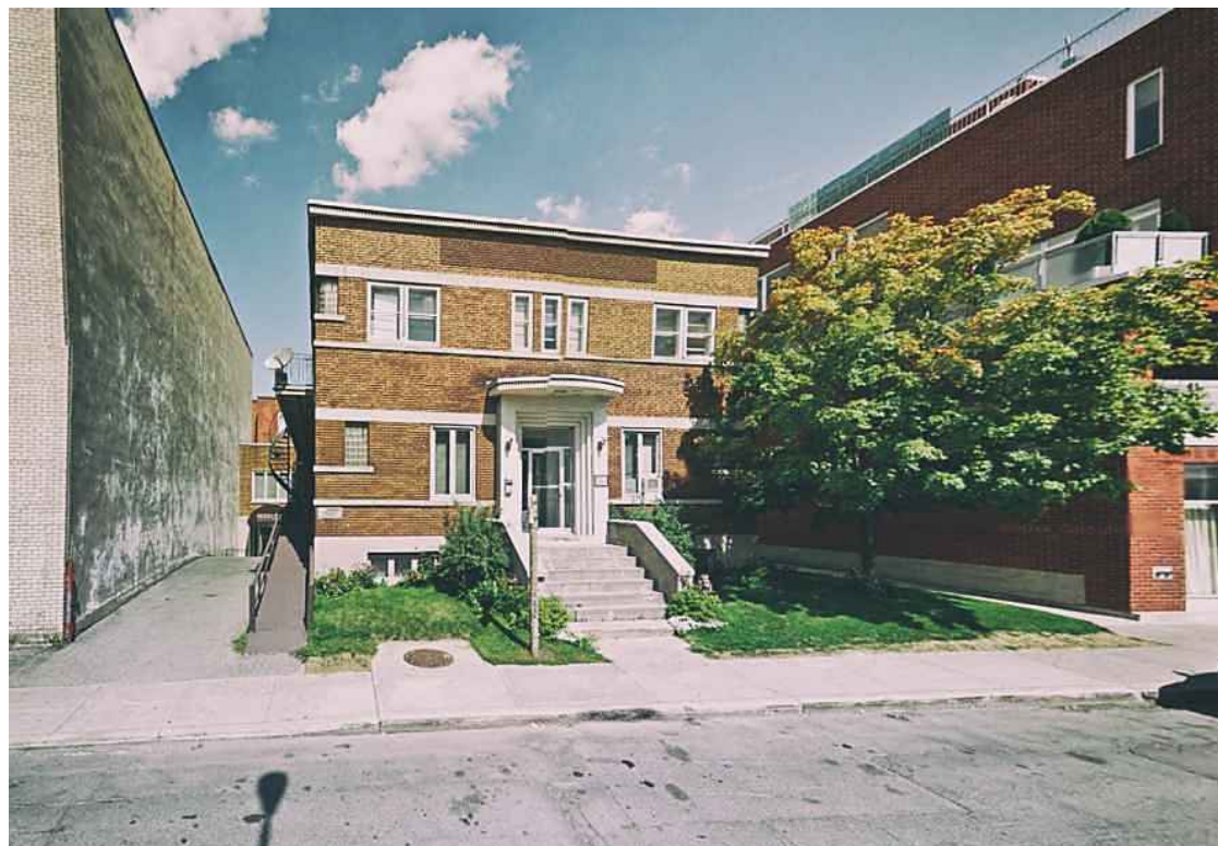
1. Façade avant à partir du Boulevard Saint-Laurent
