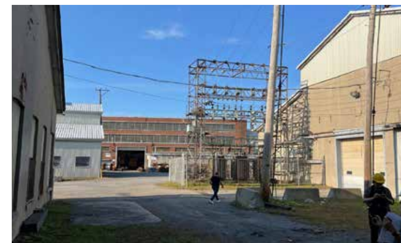
174. Vue d'une cour vers le bâtiment 3
