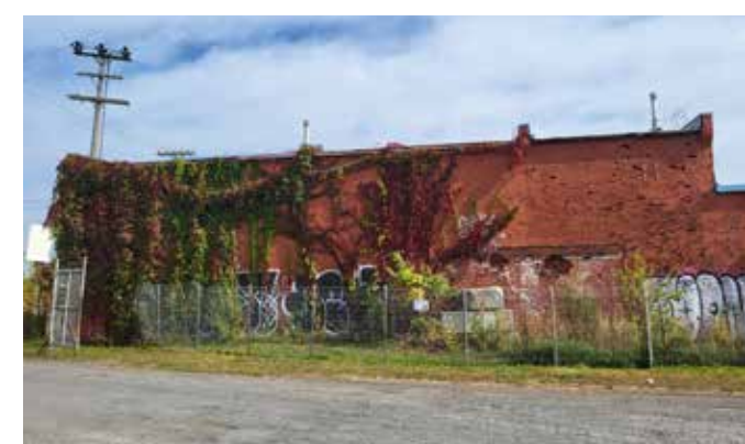
129. Façade ouest du bâtiment 20-21
