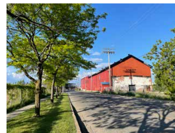
123. Couvert végétal sur le boulevard Saint-Joseph devant le bâtiment 30-31-32
