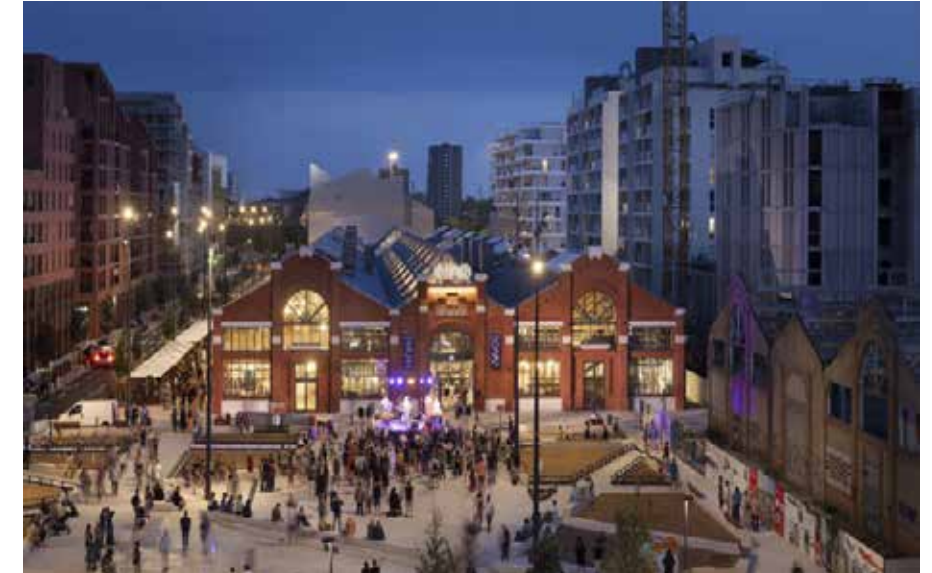
188. Immeubles d'habitation adjacent aux Halles de la Cartoucherie
