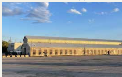
141. Vue du bâtiment 4 (atelier d'usinage et d'assemblage)
