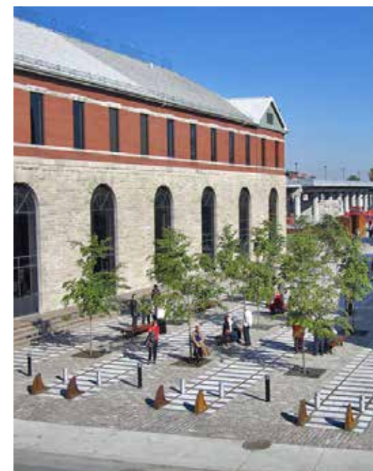
43. Exemple d'aménagement d'espace public avec traces ferroviaires - Square Dalhousie à Montréal |
