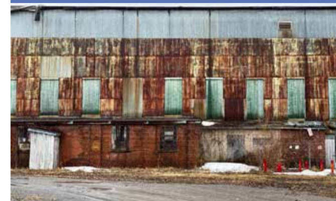
45. Patine des matériaux à préserver
