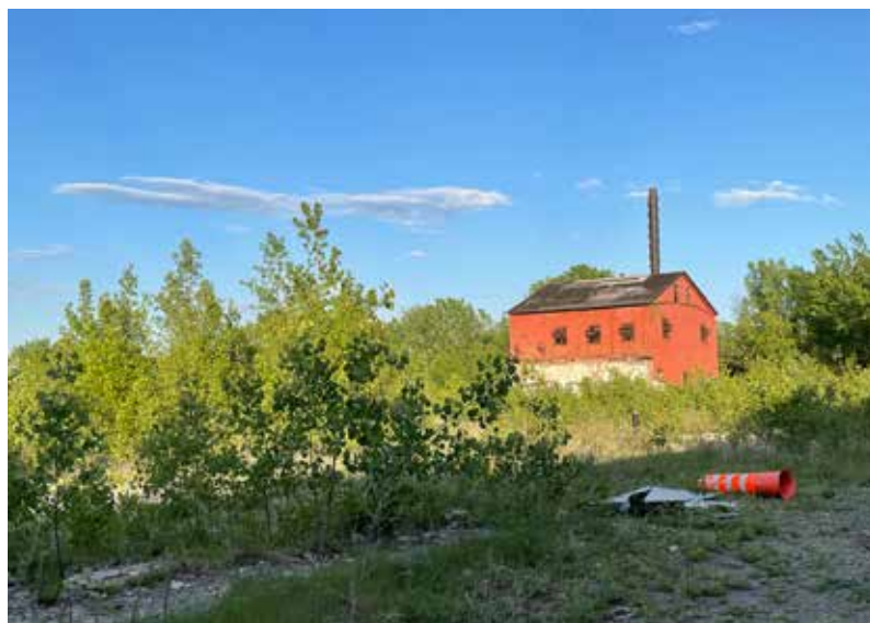
12. État de conservation variable des différents bâtiments
