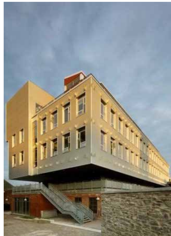
90. Exemple d'insertion de bâtiment avec surhaussement - Evergreen Brick Works, Toronto
