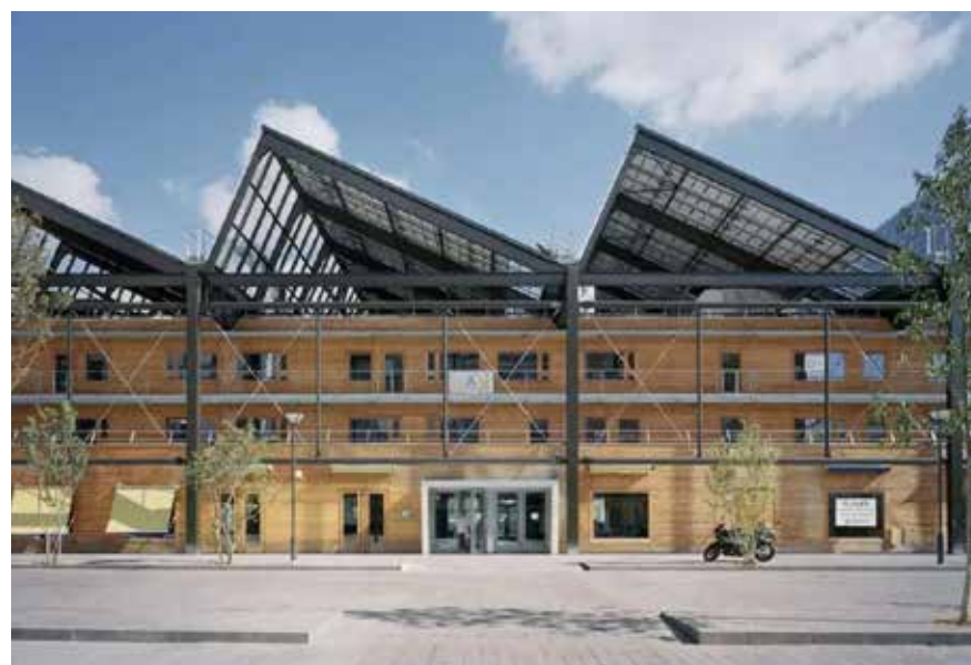
13. Production d'énergie sur un bâtiment d'intérêt patrimonial, halles SNCF à Paris
