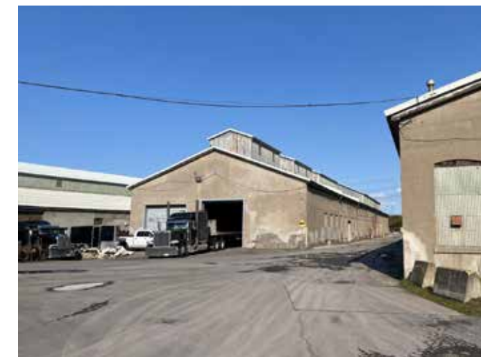
168. Vue sur le bâtiments 9 depuis la cour centrale
