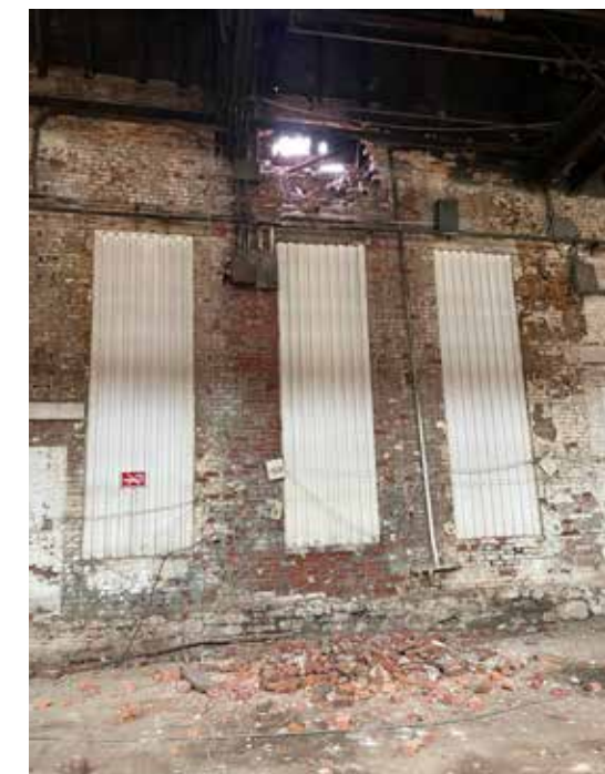
66. Mur de brique et ouvertures, bâtiment 29
