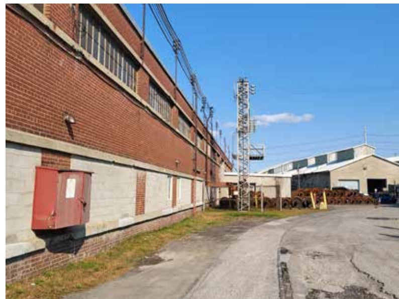
162. Vue d'une voie ferrée le long du bâtiment 3
