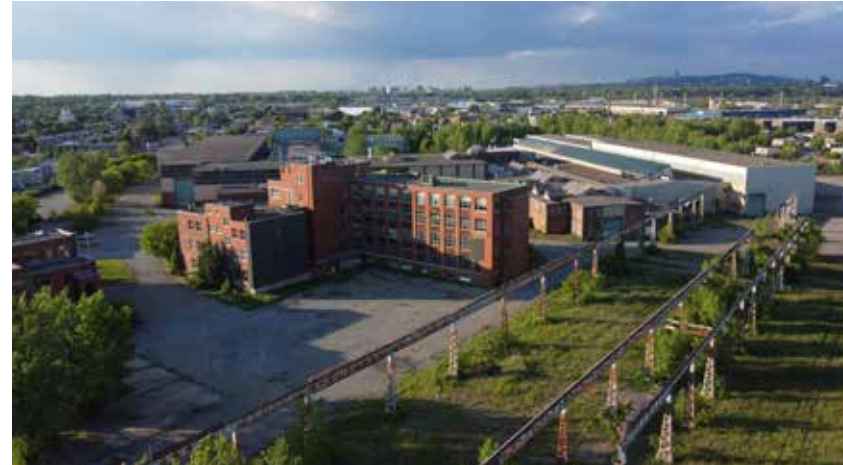
6. Vue aérienne de la Dominion Bridge (ouest et est), avec les bâtiments administratifs en premier plan
