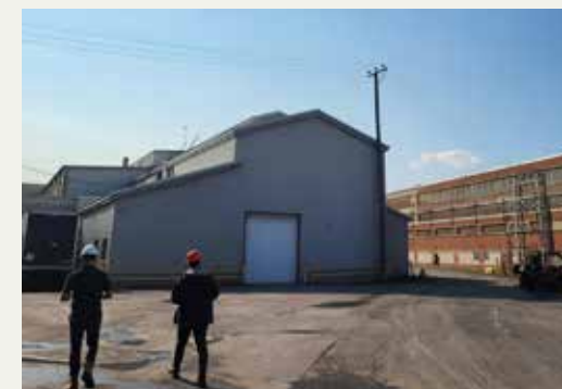
147. Vue du bâtiment 10 (atelier électrique)
