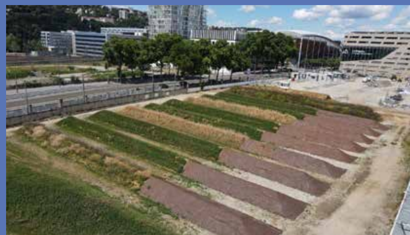
22. Exemple de site en cours de décontamination des sols
