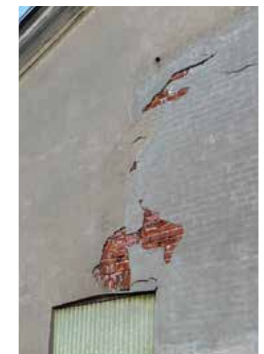
169. Mur en briques sous le crépis
