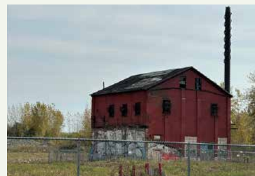
117. Vue de l'ancienne chaufferie
