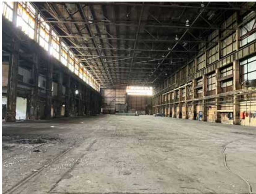
70. Halle du bâtiment 107
