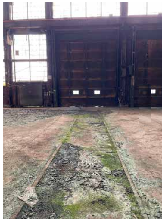
75. La connexion de voies ferrées avec la chaîne de production intérieure
