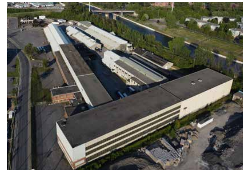
177. Vue aérienne sur les bâtiment 1 et 16 et sur l'ensemble du complexe
