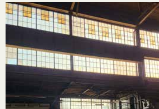
153. Vue intérieure sur la fenestration en bandeaux
