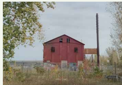
116. Vue de l'ancienne chaufferie
