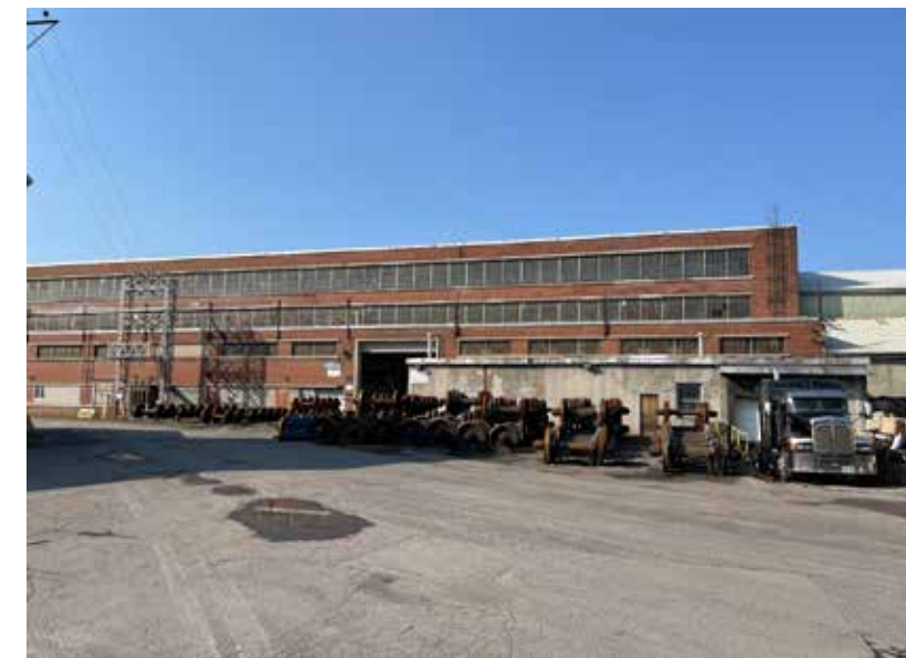
163. Vue sur le bâtiment 3 depuis la cour centrale
