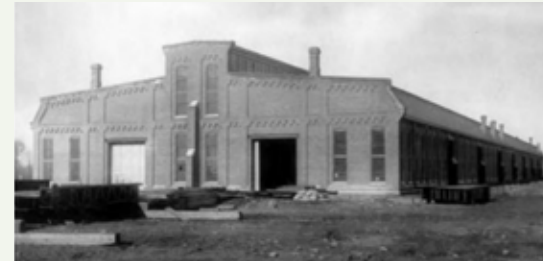
46. Atelier principal (bâtiment 29) de la Dominion Bridge vers 1890
