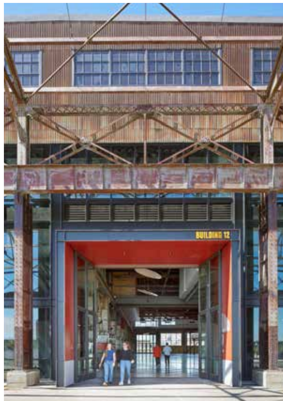
189. Exemple de conversion d'une grande ouverture
