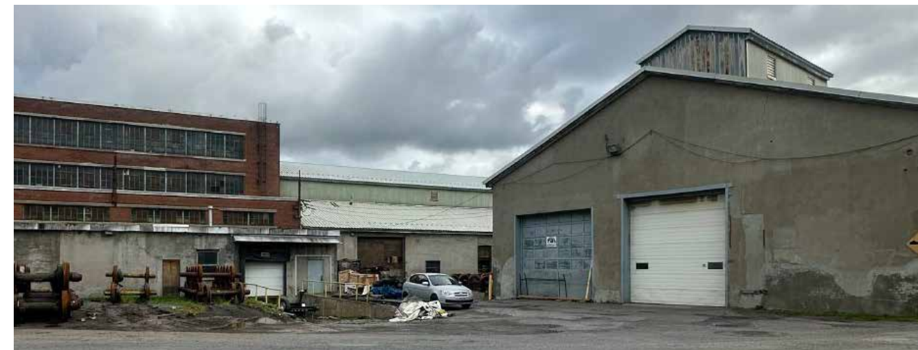
172. Vue sur les bâtiments 9, 3 et 4
