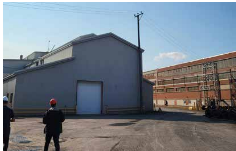
170. Bâtiment 10 (atelier électrique) en premier plan et bâtiment 3
