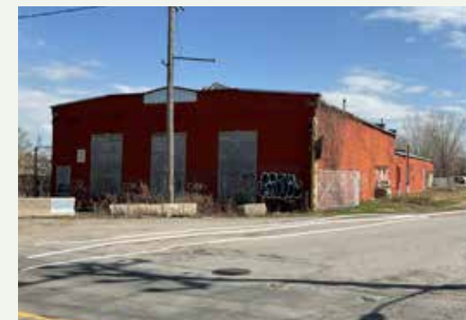
119. Vue de la façade du bâtiment 20
