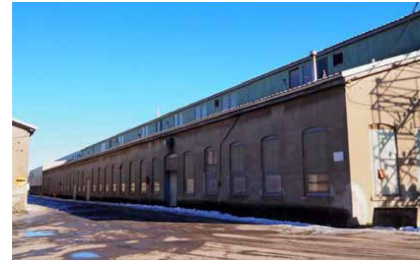
171. Mur latéral nord du bâtiment 14
