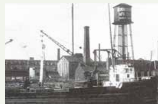
118. Vue de l'ancienne chaufferie vers 1911
