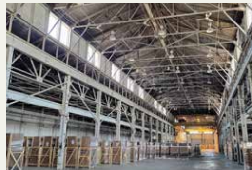
151. Vue intérieure du bâtiment 14
