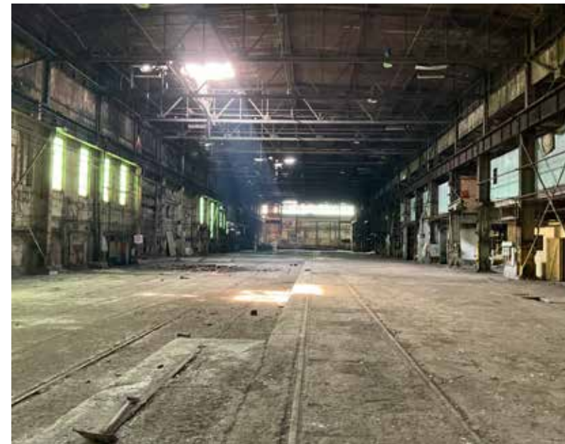
68. Longue halle et voie ferrée, bâtiment 9
