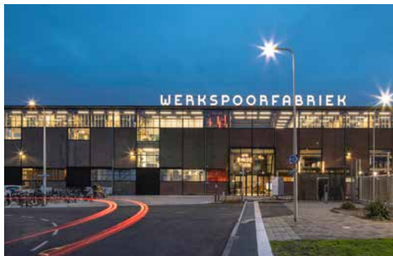
185. Exemple façade d'atelier industriel -
