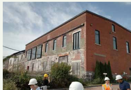
113. Vue arrière du bâtiment 31
