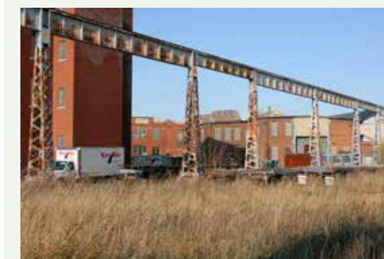
32. Pont roulant dans la Dominion Bridge
