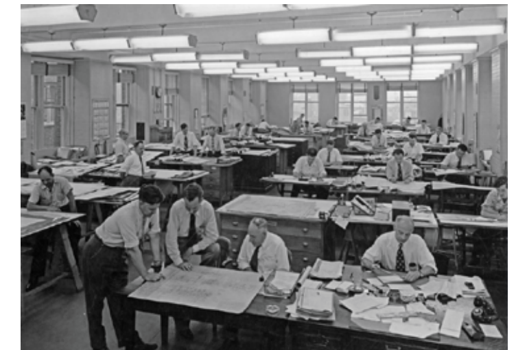
92. Les ingénieurs de la Dominion à l'œuvre, 1949
