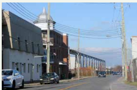
24. Percées vers les ponts roulants près de l'intersection du boulevard Saint-Joseph et 6 e Avenue
