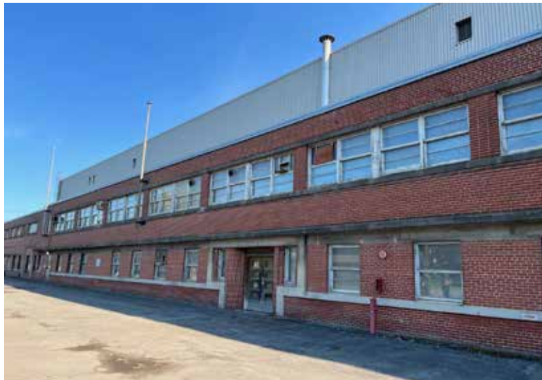
175. Entrée principale du bâtiment 3
