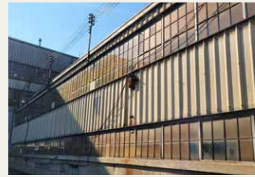
152. Vue coté cours du bâtiment 2
