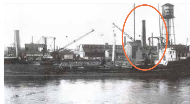
126. Vue du secteur de l'ancienne cheminée de la chaufferie, vers 1911 (Source :
