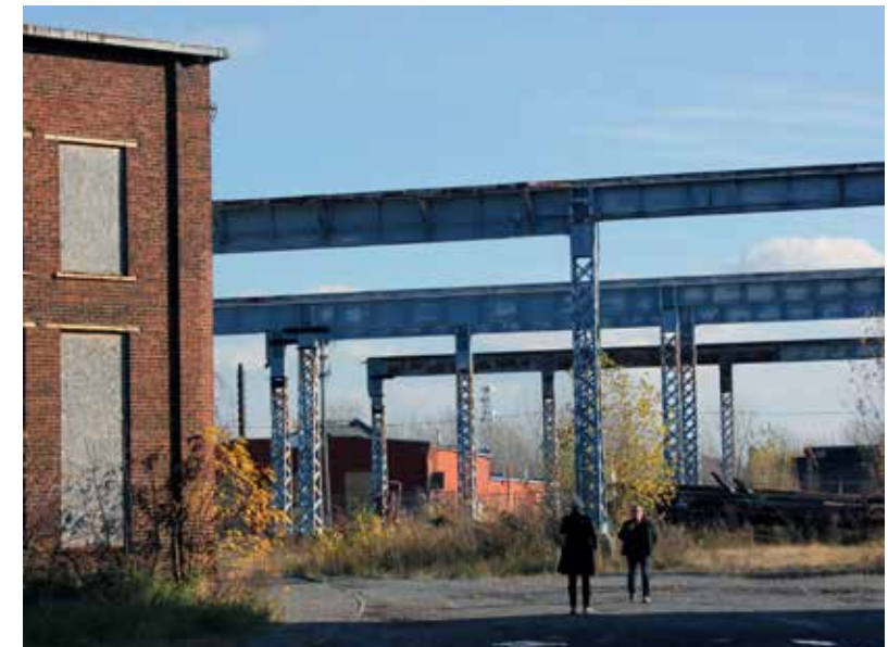
62. Vues au travers des ponts roulants vers la Stelfil
