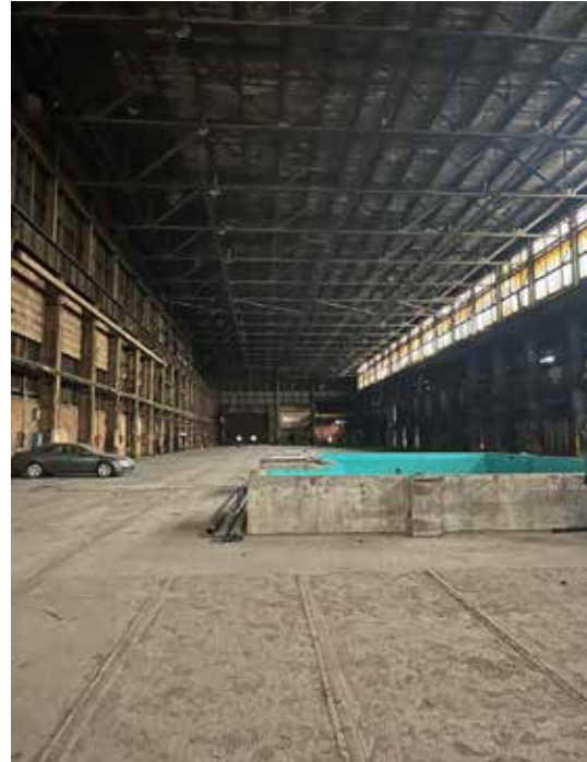
76. Longues halles du bâtiment 107
