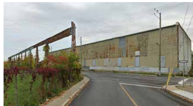
108. Implantation en faible recul du bâtiment 101
