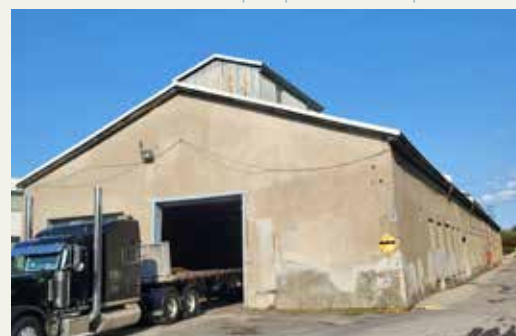
144. Vue d bâtiment 9 (ancienne chaufferie)xx
