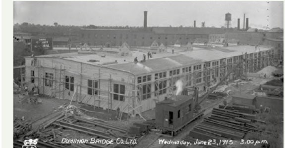
51. Halle en construction vers 1915
