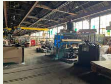
98. Structure d'acier de type Fink
