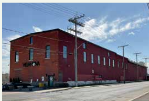
114. Vue avant des bâtiment 31-32-33
