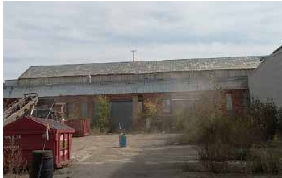
65. Vue de la façade ouest du bâtiment 29
