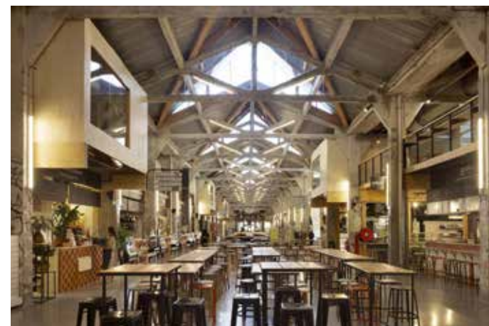
187. Exemple de préservation des structure en acier lors de nouveaux aménagements (Source
