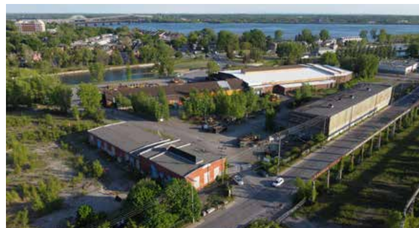
8. Vue aérienne de la Cintube et une partie de la Stelfil
