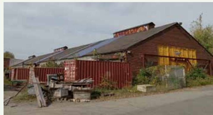
99. Forme triangulaire du bâtiment 104
