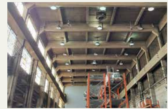
155. Vue intérieure les structures en béton armé
