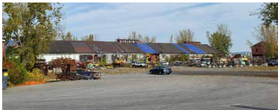
104. Volumétrie triangulaire allongée, et relation visuelle avec la chaufferie
