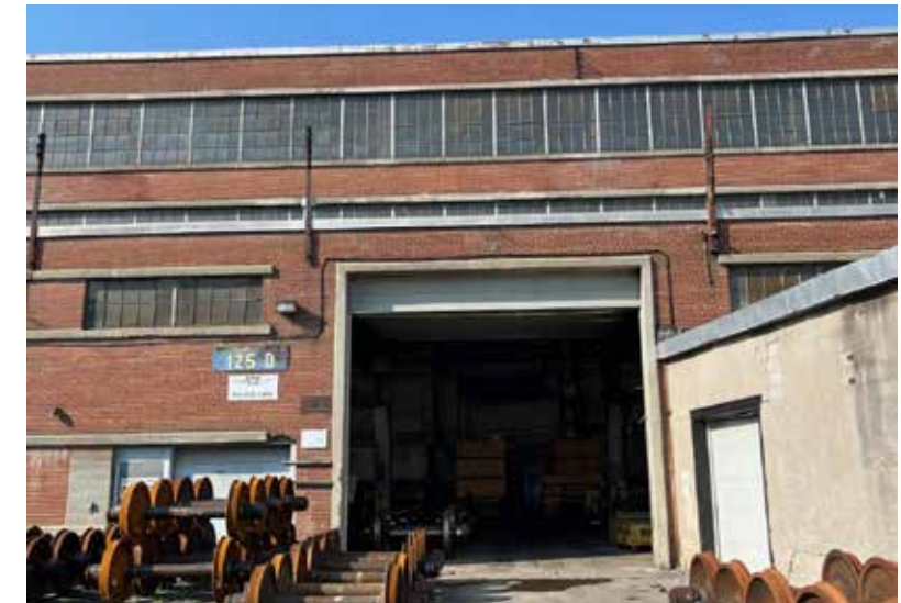
178. Vue une ouverture d'envergure du bâtiment 3
