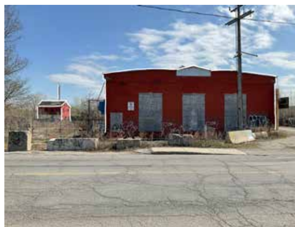
122. Vue du bâtiment 20-21 et de la chaufferie depuis le boulevard Saint-Joseph
