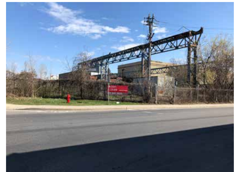
60. Vue vers les ponts roulants et les halles au coin de la 6 e avenue et la rue William-MacDonald
