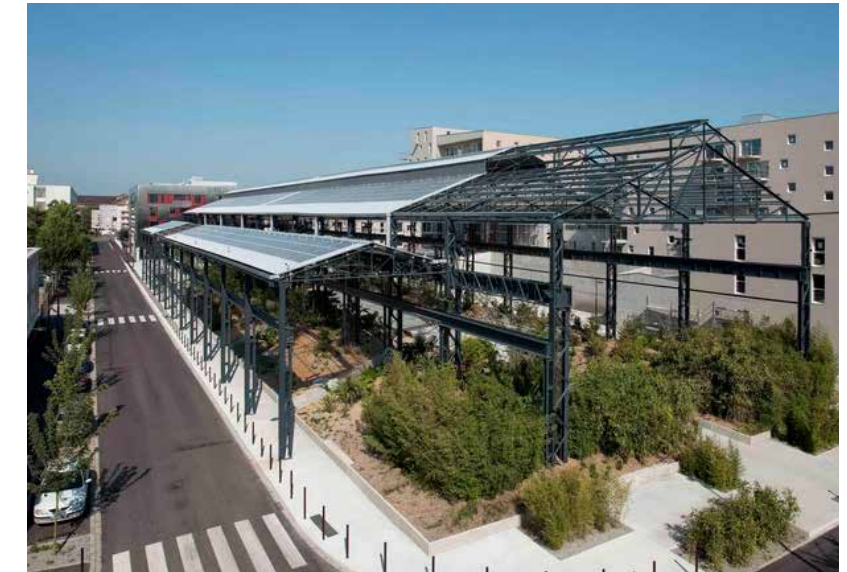
72. Exemple de structure réutilisée comme espace semi-extérieur
