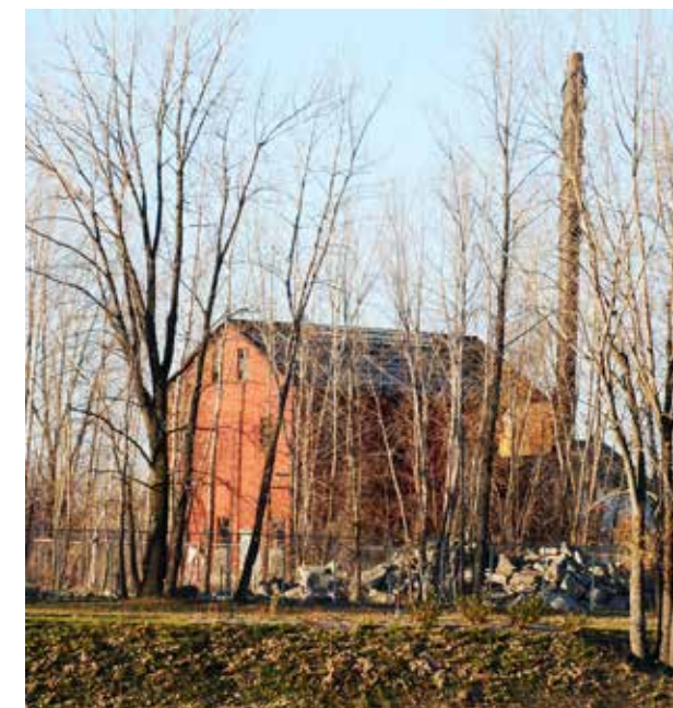
125. Vue de la chaufferie depuis le canal de Lachine
