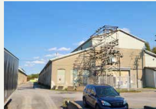
150. Vue du bâtiment 14 (atelier de tôlerie)
