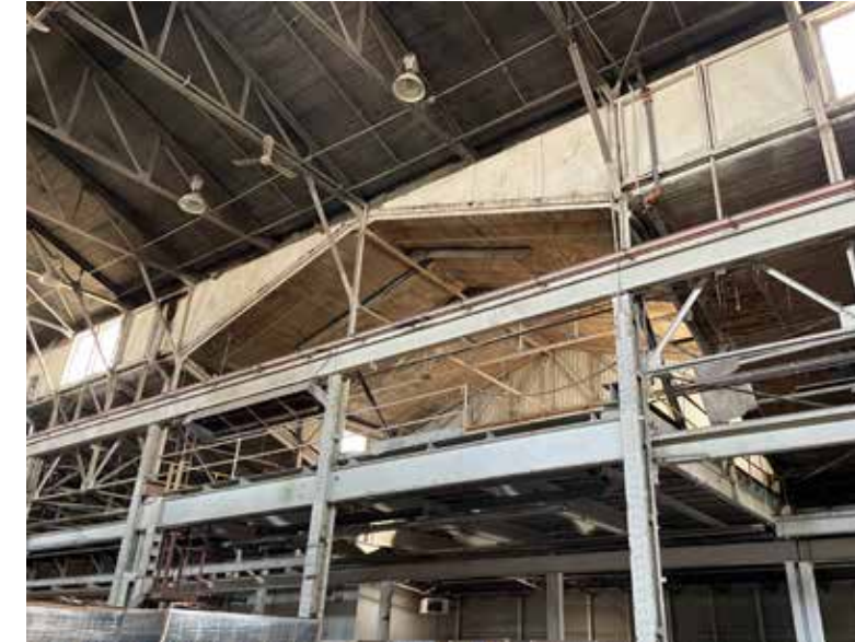
166. Vue intérieure sur les structures d'acier du bâtiment 14
