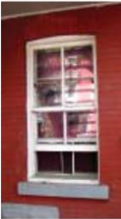
Fenêtre à guillotine \frac{1}{2} - \frac{1}{2} avec croisillon
