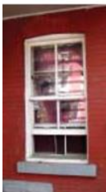
Fenêtre à guillotine \frac{1}{2} - \frac{1}{2} avec croisillon
