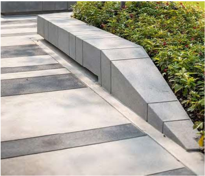
Banc en béton intégré
