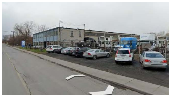
5 - Bâtiment voisin (435 rue Norman) – Google Earth
