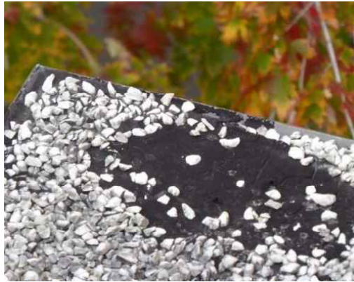
Toit de balcon, 7342
