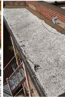
Toit de balcon, 7348
