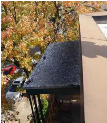
Toit de balcon, 7342
