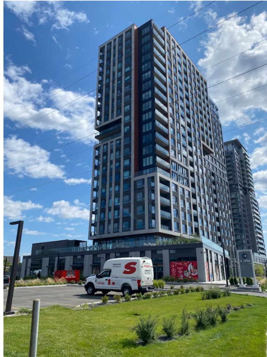
Image 13. Tour Voltige (2020, rue Sauvé Ouest)
