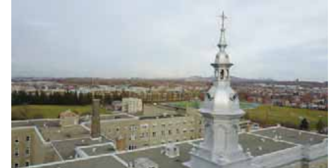
Ensemble des bâtiments
