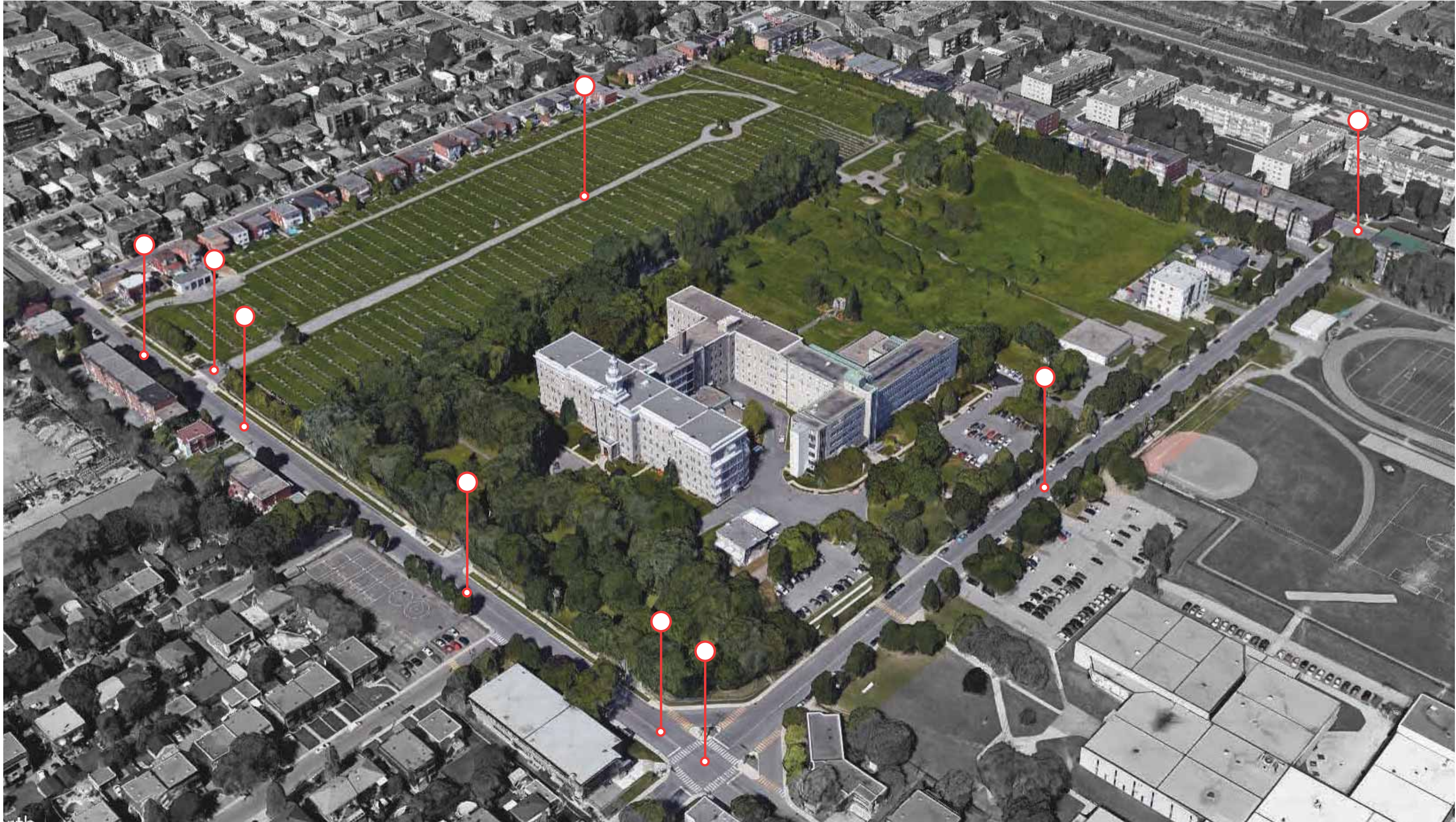
Vue aérienne - Ensemble du site dans son contexte
