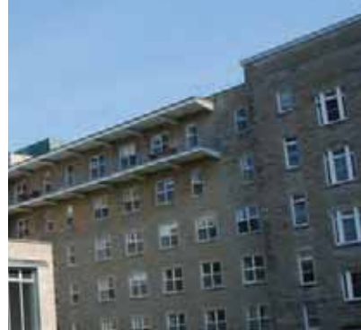
Jonction arrière entre bâtiments B et C
