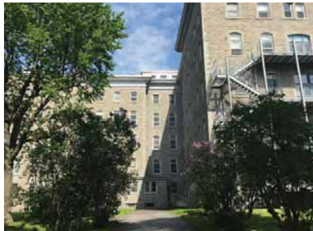
Jonction entre les ailes A et B
