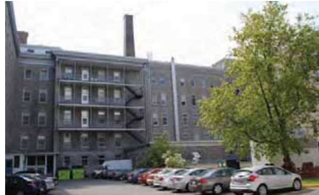
Vue vers cour intérieure à la jonction des ailes A-B-C
