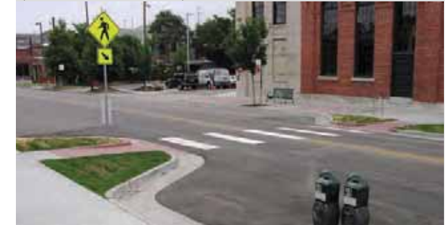
Avancée de trottoir (source : Richard Drdul)
