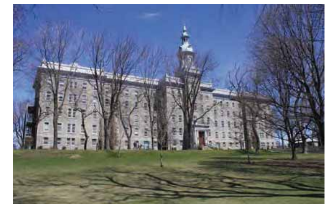
La façade principale, en surplomb de la rue Provost avec ses parterres gazonnés (Source : Patri-Arch, 2016)
