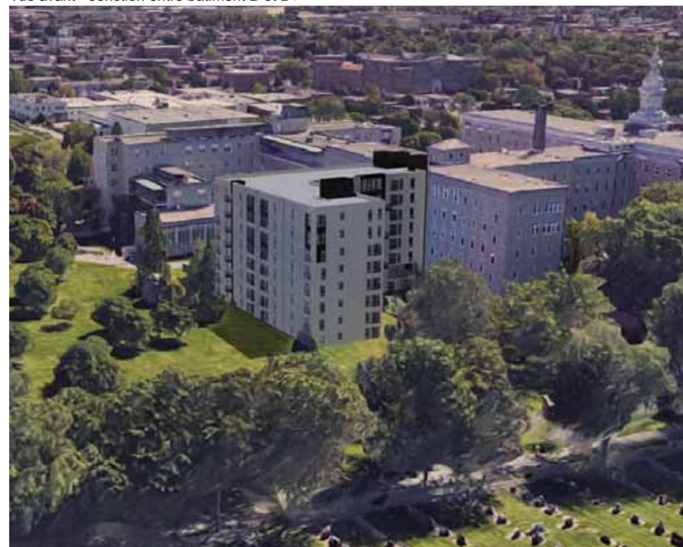
Vue arrière - Jonction entre bâtiment B et B+
