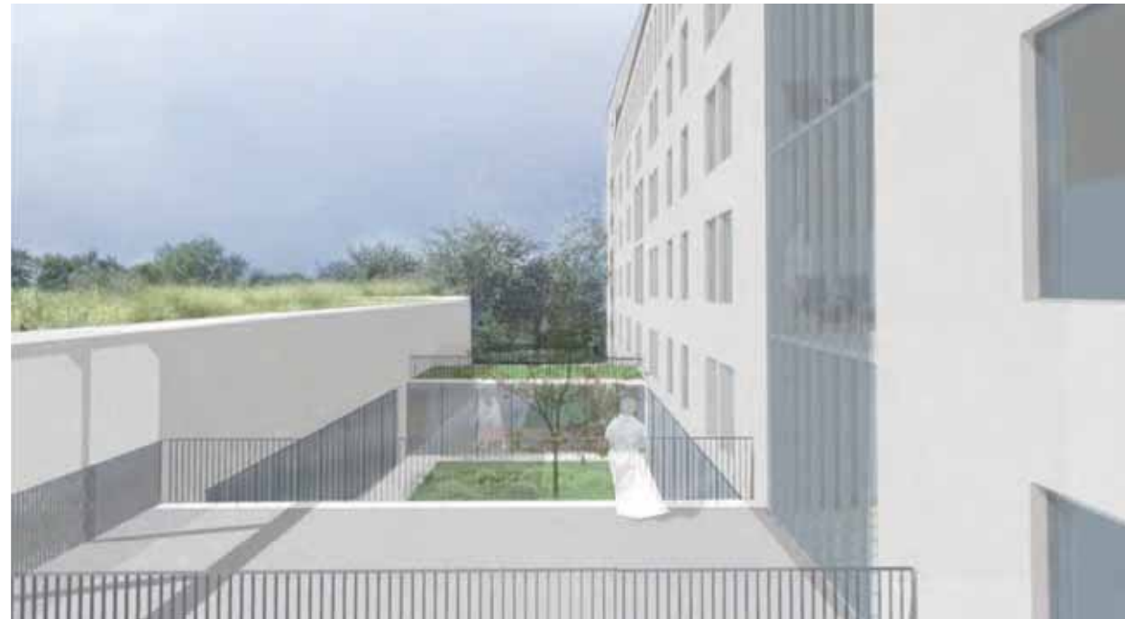
A - Vue toiture jardin vers le verger
