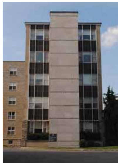
Fenestration verticale foncée - Bâtiment C
