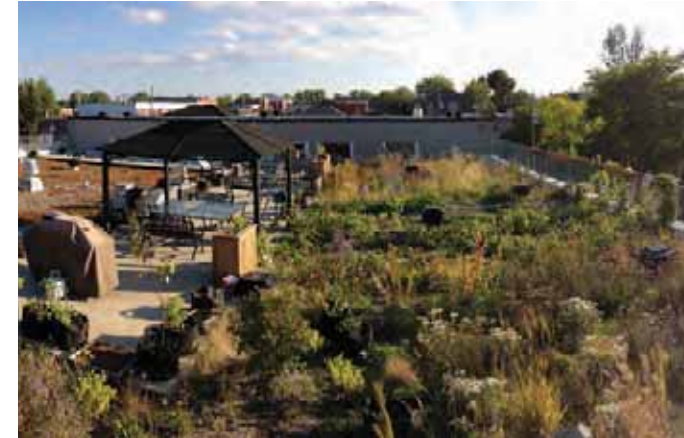
Toiture verte et terrasse du Regroupement de Lachine
