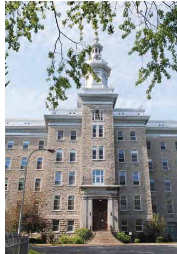
Façade avant de l'aile A
