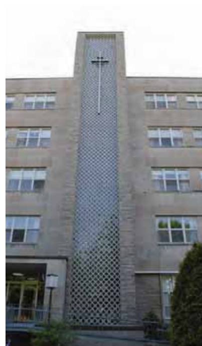
Traitement de façade vertical du bâtiment C, exprimant l'escalier
