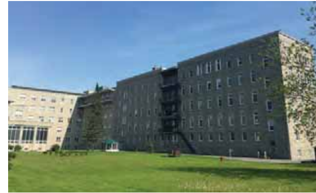
Jonction entre les ailes B et C
