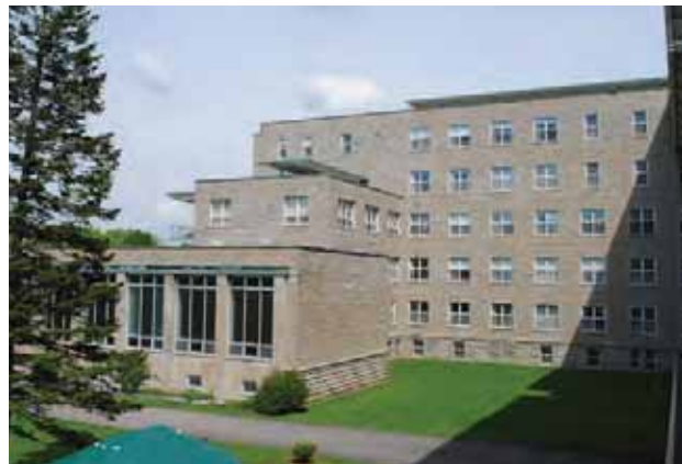
Vue vers cour intérieure à la jonction de la piscine et de l'aile C
