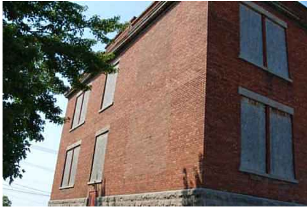
Obturation de deux baies de la façade ouest. Source : Mario Brodeur, juillet 2012.
