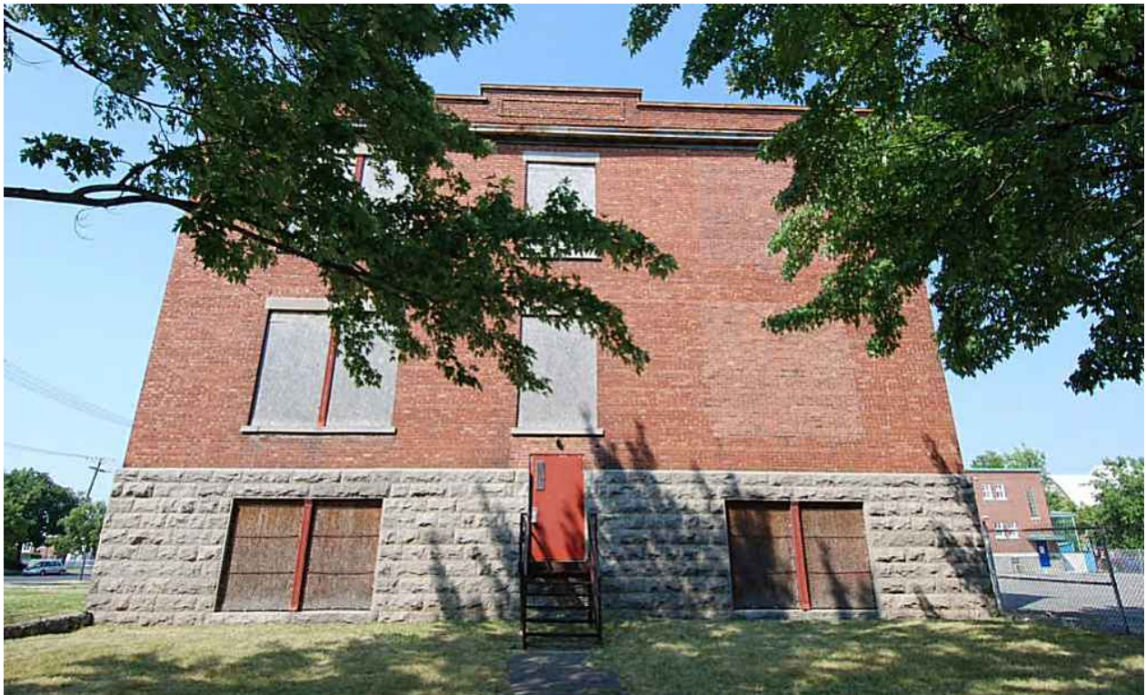
Façade ouest (6 e avenue). Source : Mario Brodeur, juillet 2012.
