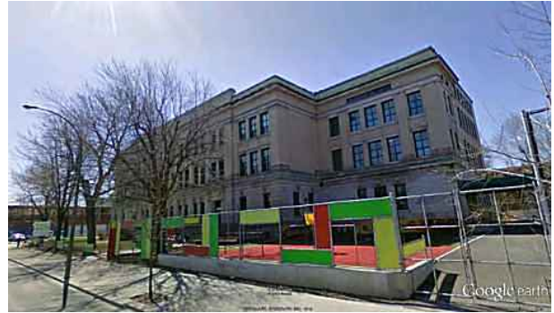
École Gabriel-Souart, 1808, avenue Papineau, construite en 1916 (Marchand, Doucet et Morissette). Source : Google Earth.
