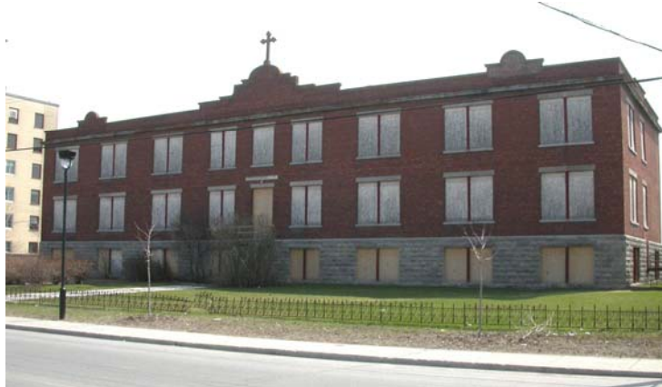
Façade principale – rue Jarry
