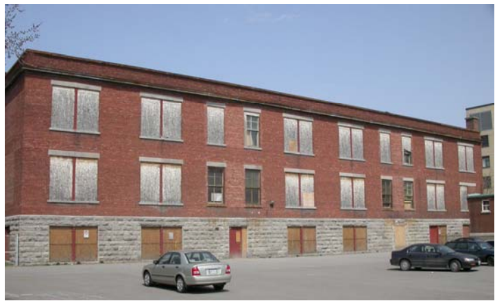
Façade arrière - est
