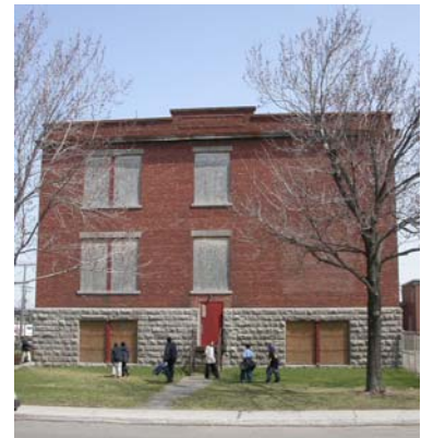
Façade latérale sud – entrée à mi-niveau
