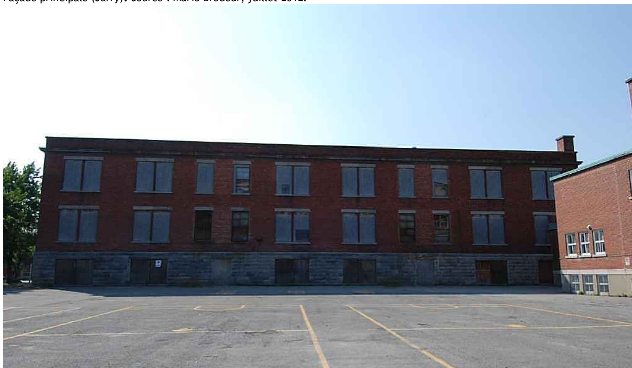
Façade sud (cour). Source : Mario Brodeur, juillet 2012.
