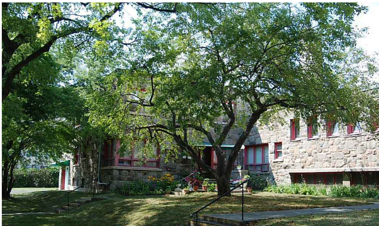
Le deuxième presbytère adjacent à l'église. Source : Mario Brodeur, juillet 2012.
