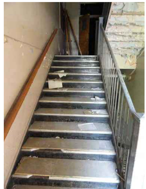
Escalier sud – marches recouvertes de contreplaqué
