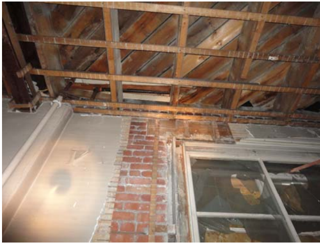
Vue intérieure d'un mur extérieur – fenêtre, maçonnerie et lattis de bois avec enduit cimentaire – la maçonnerie intérieure est dans un état stable et sa réfection est possible ;
