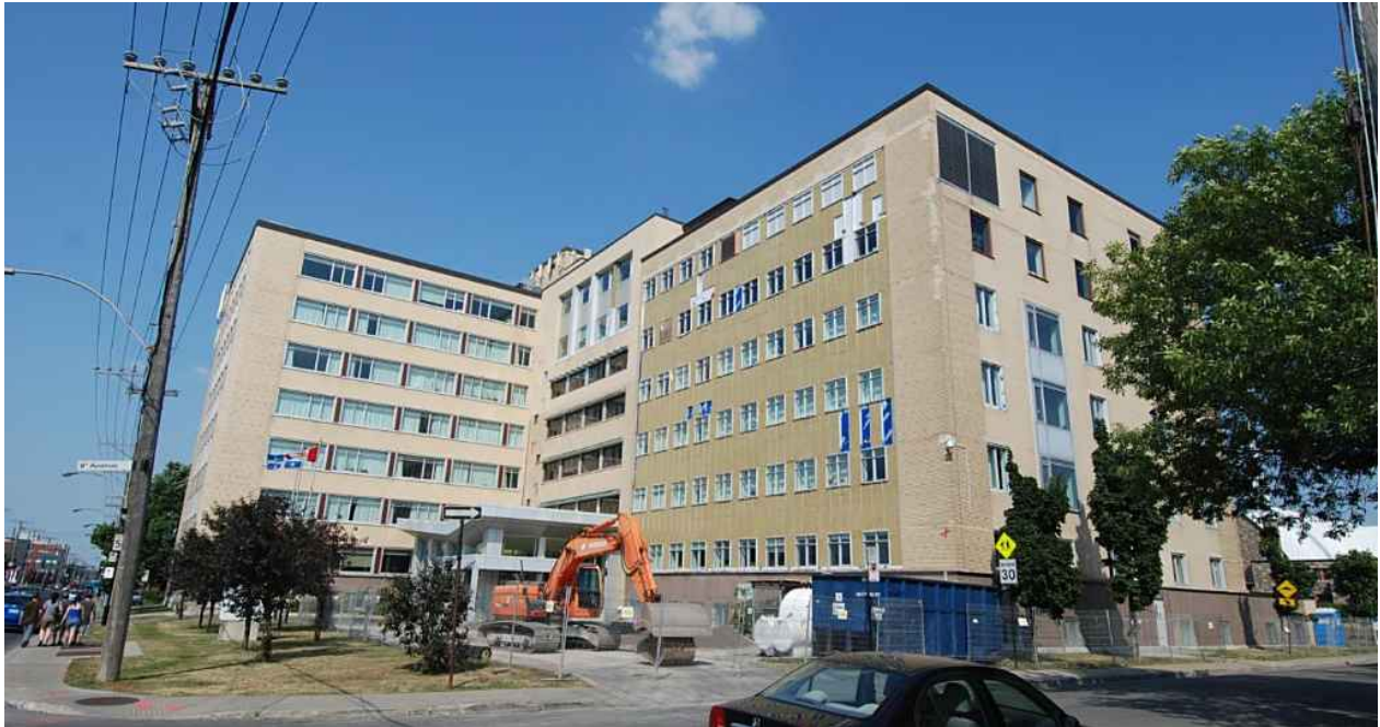
L'ancien hôpital Saint-Michel aujourd'hui Centre d'hébergement de Saint-Michel. Source : Mario Brodeur, juillet 2012.
