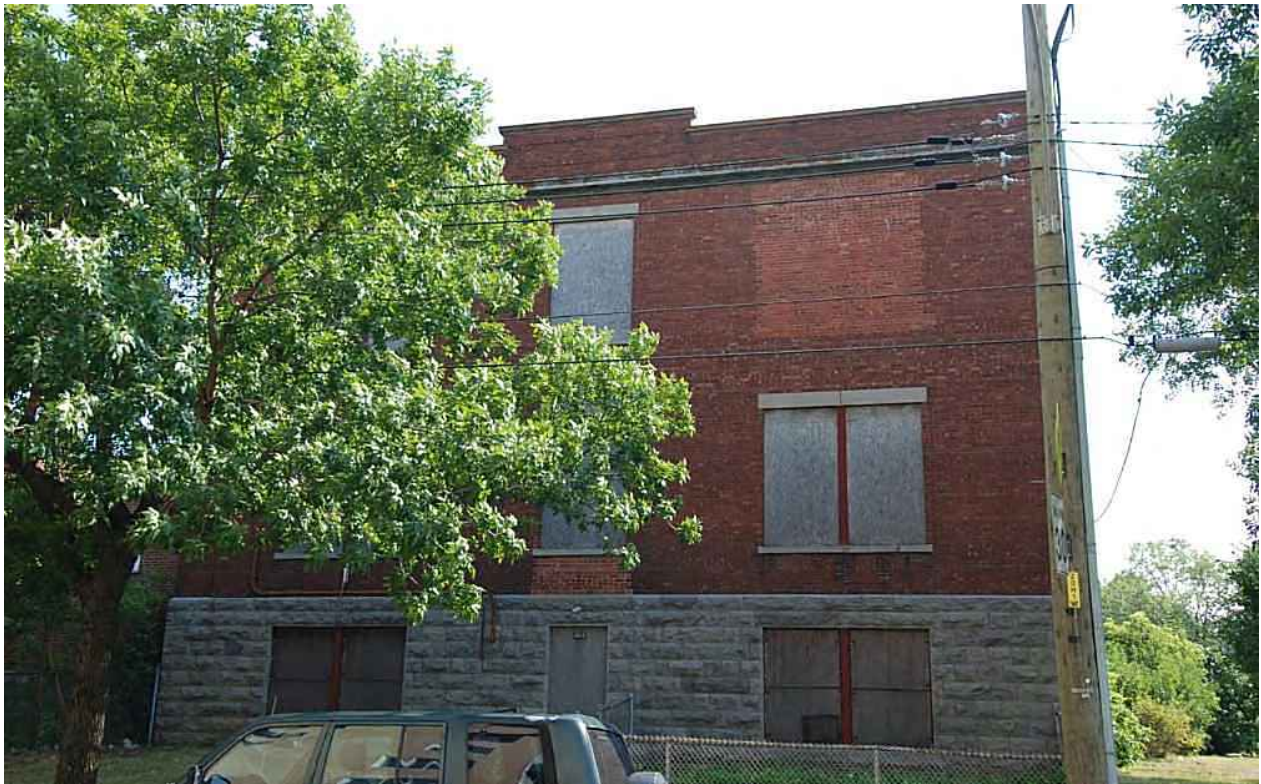
Façade est (8 e avenue). Source : Mario Brodeur, juillet2012.
