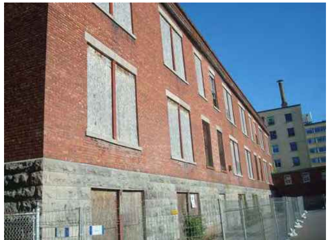
Certains linteaux de pierre peuvent être récupérés, certaines sections de maçonnerie portent à croire qu'un simple rejointoiement serait suffisant – L'état général de la maçonnerie demande d'importants travaux de restauration mais l'ensemble est tout à fait récupérable.
