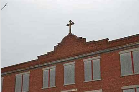
Le fronton surmontée d'une croix de la façade principale (source : Ville de Montréal, février 2013)
