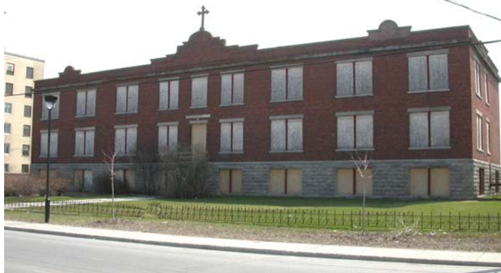
Façade principale – rue Jarry
