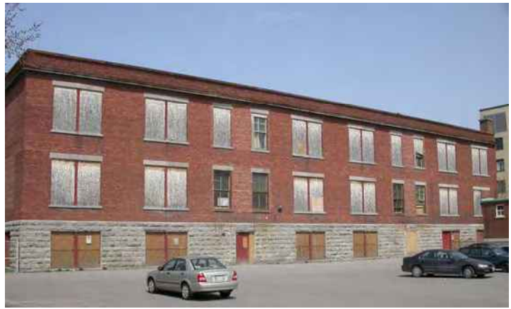
Façade arrière - est
