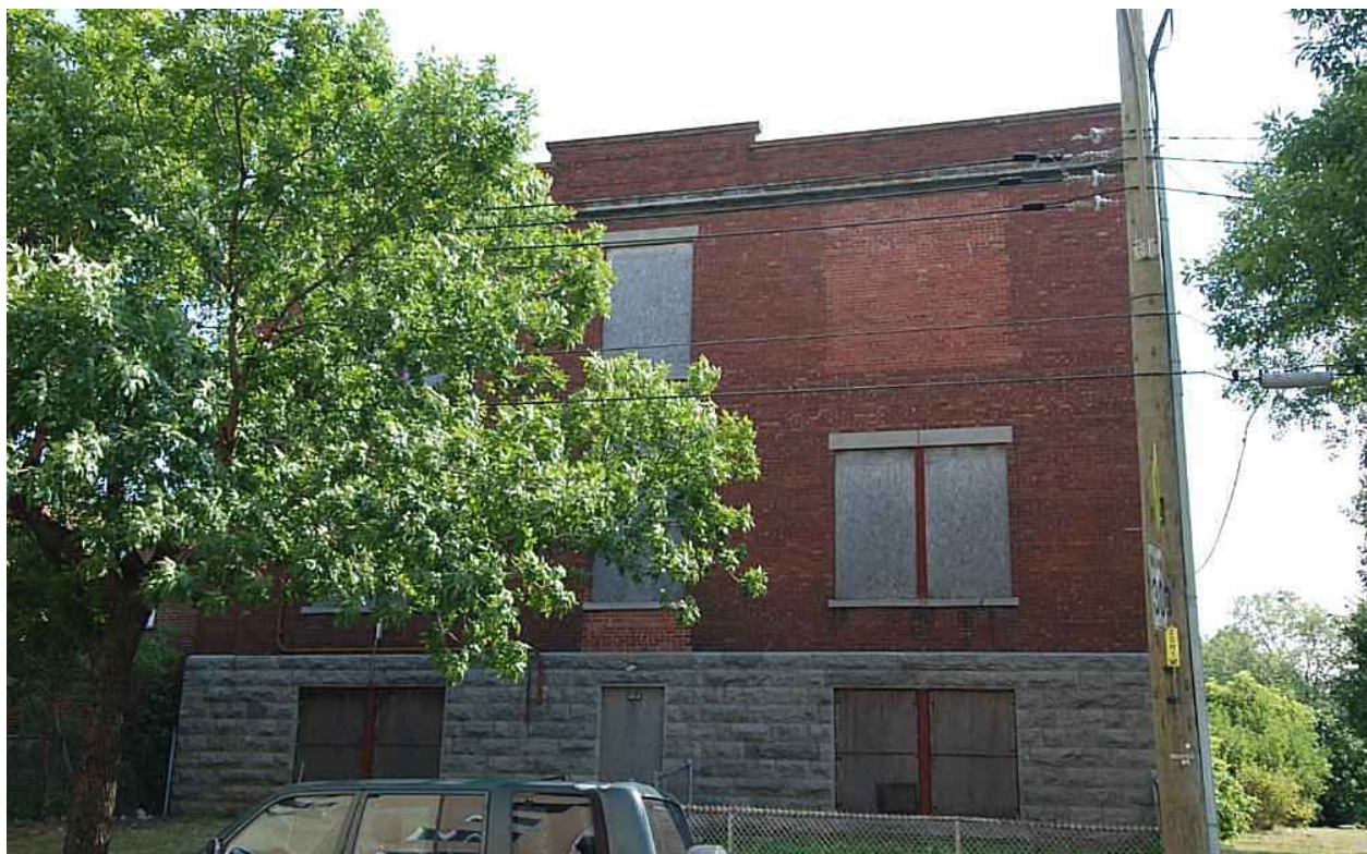
Façade est (8 e avenue). Source : Mario Brodeur, juillet2012.
