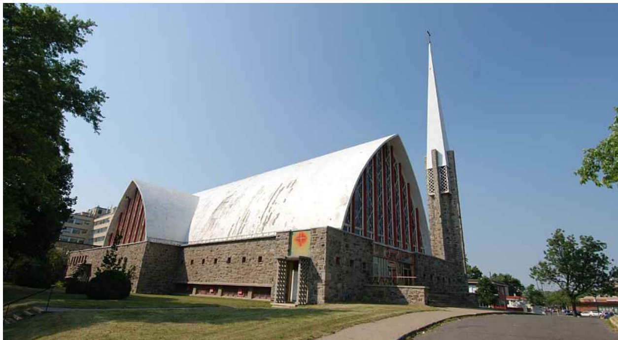
La deuxième église Saint-Bernardin-de-Sienne. Source : Mario Brodeur, juillet 2012.
