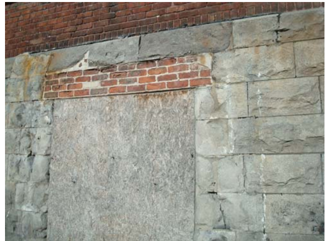
Travaux de fermeture du mur extérieur. La dégradation du mur de pierre autour est importante.
