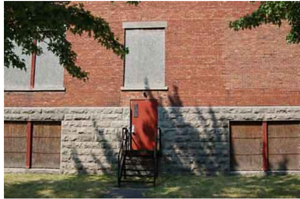
Probable percement d'une nouvelle porte de la façade ouest. Source : Mario Brodeur, juillet 2012.
