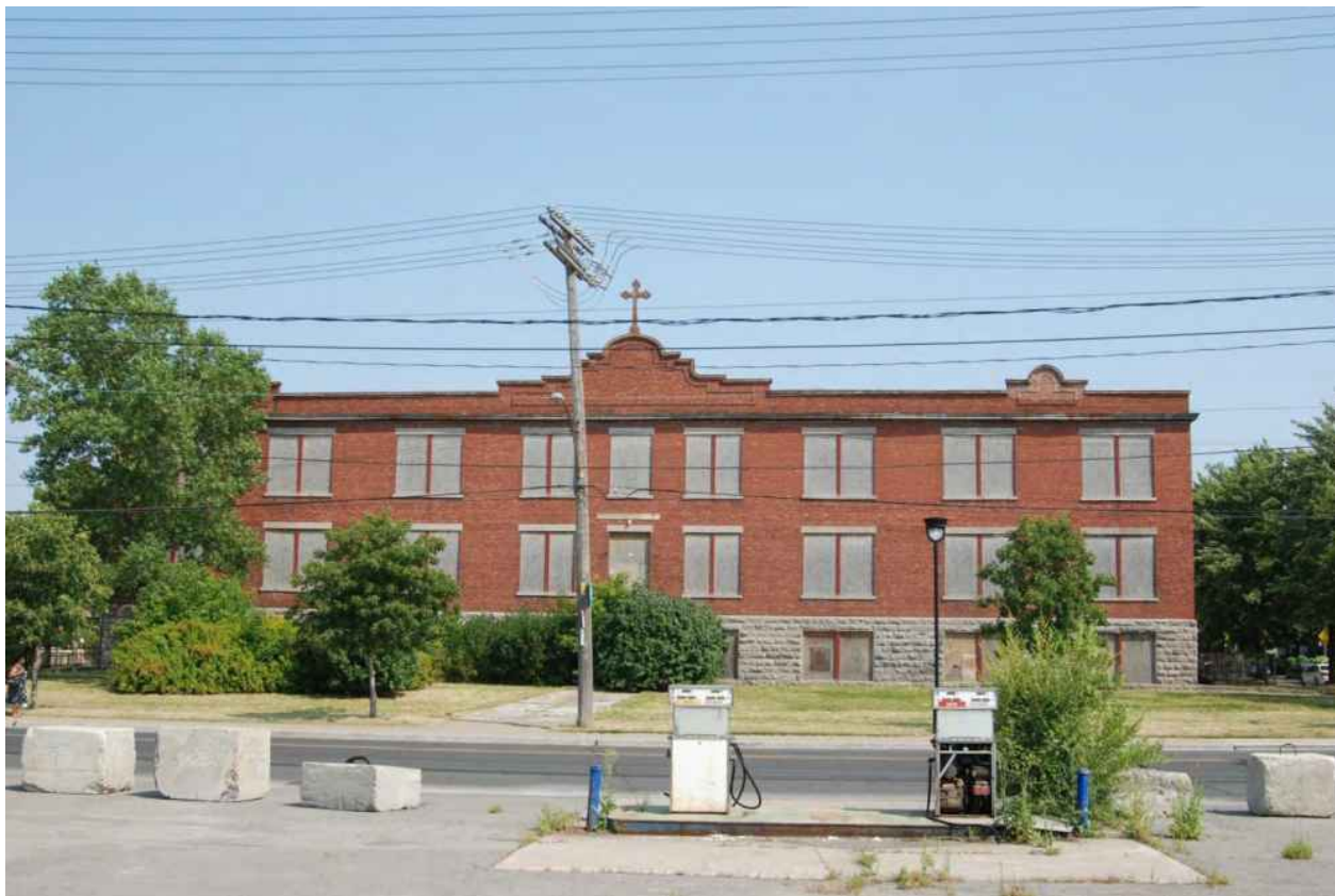
Façade principale (Jarry). Source : Mario Brodeur, juillet 2012.
