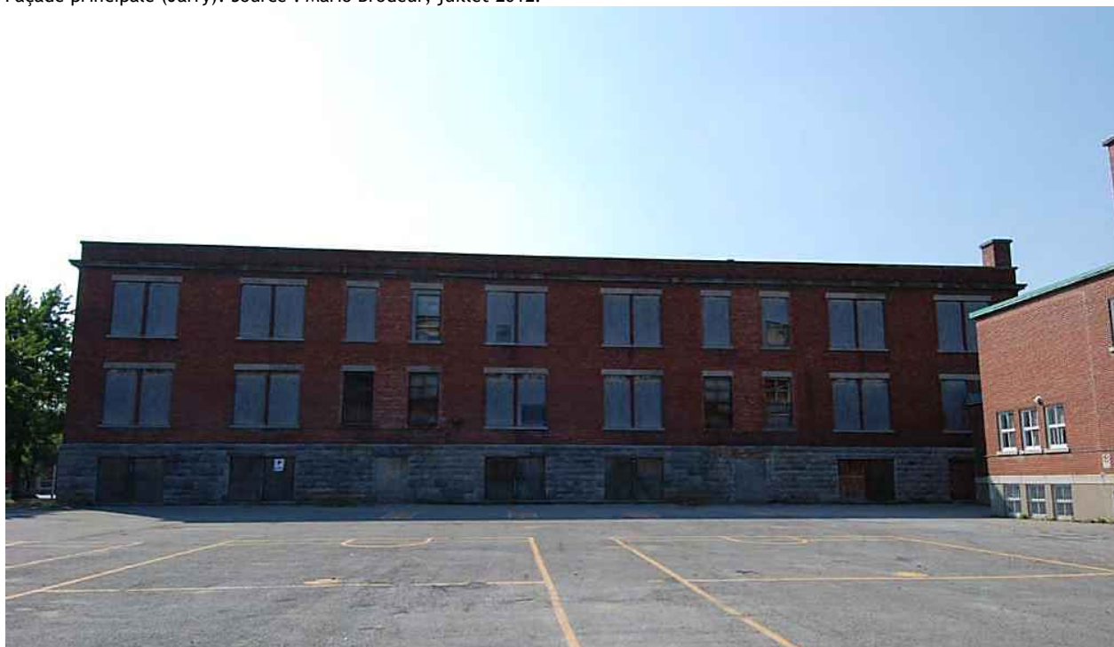
Façade sud (cour). Source : Mario Brodeur, juillet 2012.
