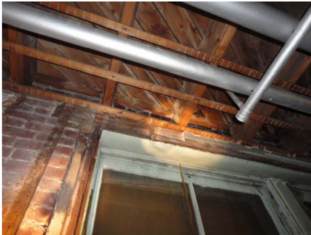
Côté intérieur d'une fenêtre dont la périphérie a été dégarnie. À partir du haut, on voit le pontage de bois, les solives encastrés dans la maçonnerie et le linteau de bois. À gauche, on aperçoit le cadre, le sous-cadre et la face intérieure du mur massif de maçonnerie. Une fourrure verticale servant à fixer le lattis de bois est encore présente
