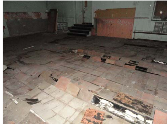
Plancher du sous sol – les éléments de bois,
