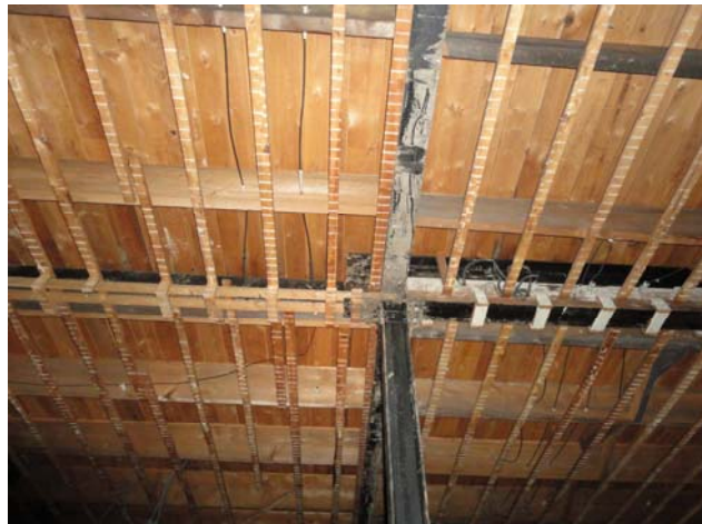
Exemple de pontage de bois en bon état – les colonnes au centre du bâtiment sont en acier et certaines poutres principales – les fourrures de bois, fixées aux solives, servaient à soutenir les lattes de bois et le plâtre ;
