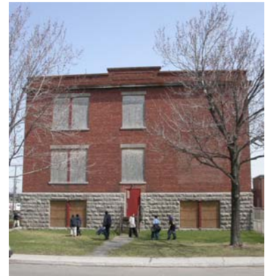
Façade latérale sud – entrée à mi-niveau
