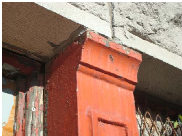
Vue rapprochée d'un pilastre central d'une fenêtre du sous-sol
