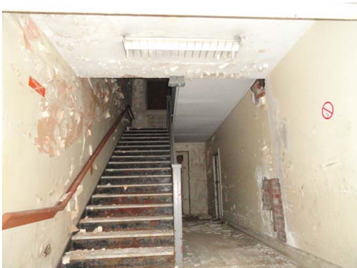
Escalier nord – l'ossature de l'escalier est saine et peut être récupérée – à droite, la cloison séparant l'escalier de la salle mécanique.
