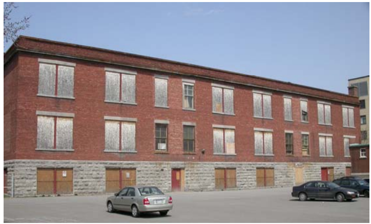
Façade arrière - est
