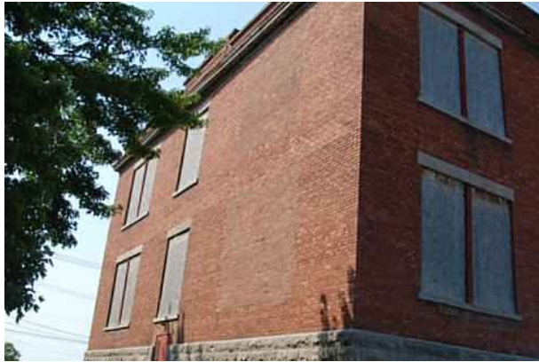
Obturation de deux baies de la façade ouest. Source : Mario Brodeur, juillet 2012.
