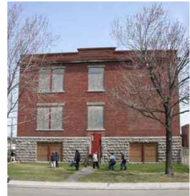
Façade latérale sud – entrée à mi-niveau
