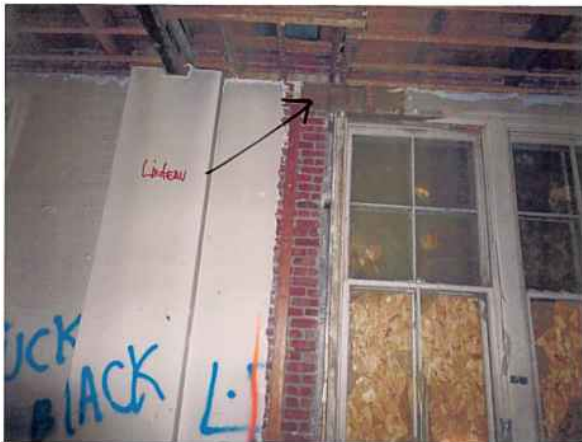
Transformation d'une porte en fenêtre à la façade est ? Source : Mario Brodeur, juillet 2012.
