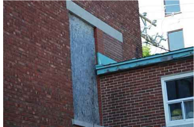
Obturation partielle de la baie au niveau du rez-de-chaussée pour le raccord du passage couvert. Source : Mario Brodeur, juillet 2012.
