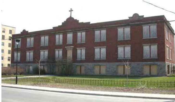
Façade principale – rue Jarry
