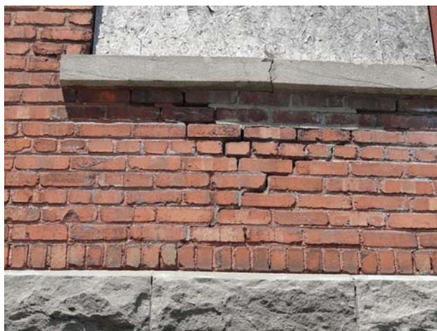
Exemple d'une partie de mur dont au moins les deux premières épaisseurs du mur massif de brique sont à enlever et reconstruire ;
