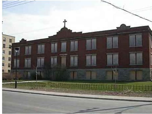
La clôture de fer ornemental à l'automne 2011. Source : BBL architectes.
