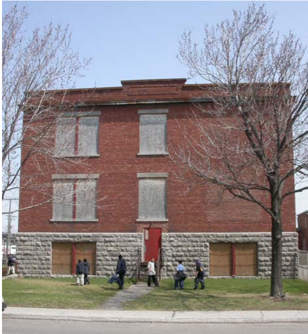
La façade sud a subi des modifications modifiant le niveau d'accès au bâtiment. Deux fenêtres ont également été murées.
