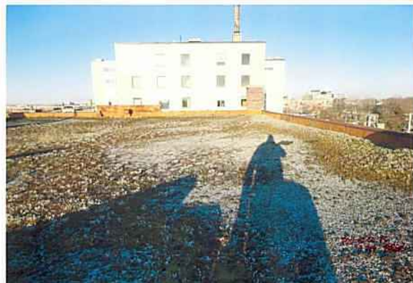
Couverture multicouche en voie de devenir un toit vert... Source : BBBL architectes, 2012.
