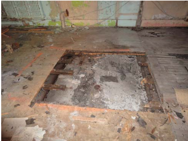
Dalle de béton dégarnie par notre entrepreneur général. On note, à la droite de l'image, l'arrêt de la dalle et le passage de tuyaux
