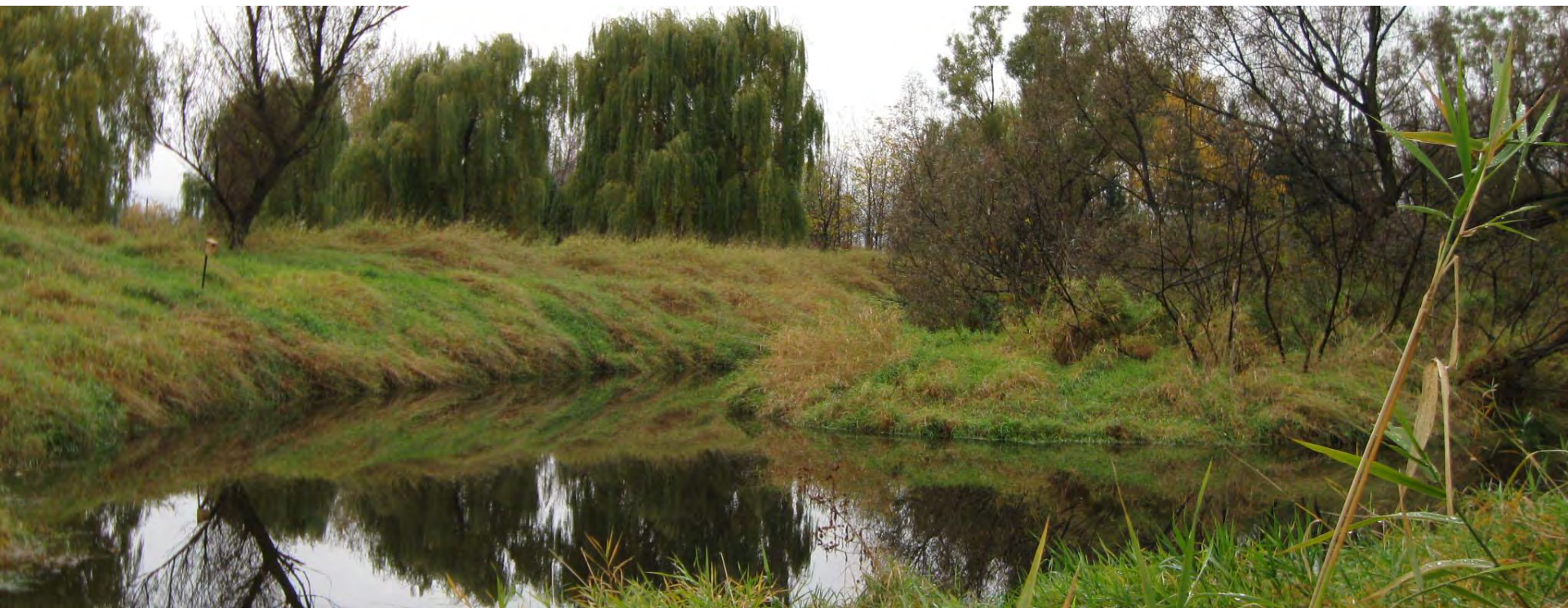
Réaménagement du secteur des marais au Parc-nature Pointe-aux-Prairies Aménagement d'un ouvrage de contrôle à l'exutoire
