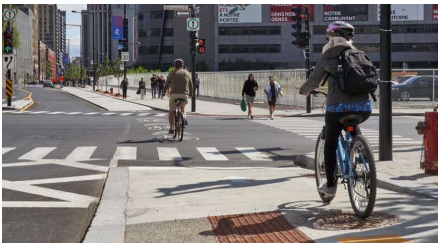
REV Peel, piste cyclable rehaussée vis-à-vis l'arrêt d'autobus avec marquage au sol et dalles podotactiles permettant de sécuriser la traversée, espace suffisant pour le déploiement de la rampe. Crédit : Ville de Montréal
