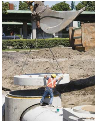
Travaux d'égouts et d'aqueduc
